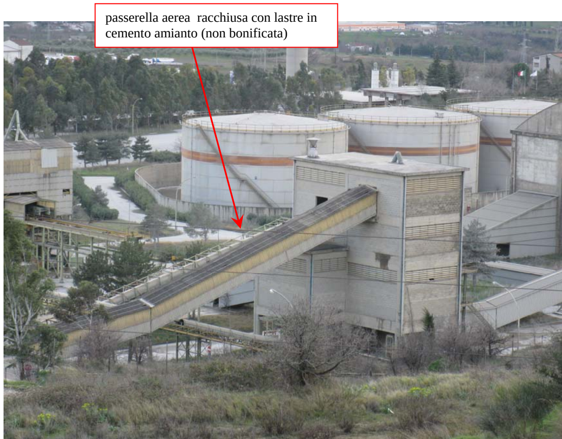
P.V. 2 - FOTO N°3: passerella aerea alloggiamento dei nastri trasportatori per la messa a deposito delle materie prime, racchiusa con lastre in cemento amianto (tratto non bonificato) – (6)
