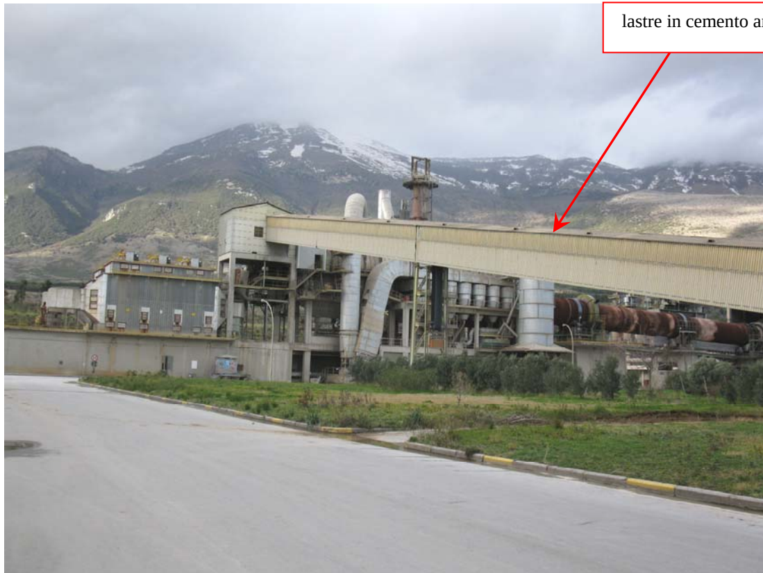
P.V. 5 - FOTO N°6: passerella aerea per alloggiamento nastro trasporto granuli alla griglia Lepol (10)- non bonificata
