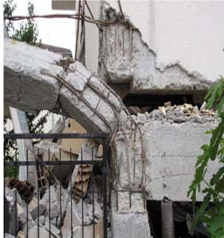
*Collasso strutturale con espulsione esterna dei pilastri in c.a. e schiacciamento del piano primo da parte dei piani sovrastanti per il cedimento del nodo pilastro-trave non adeguatamente armato.*
