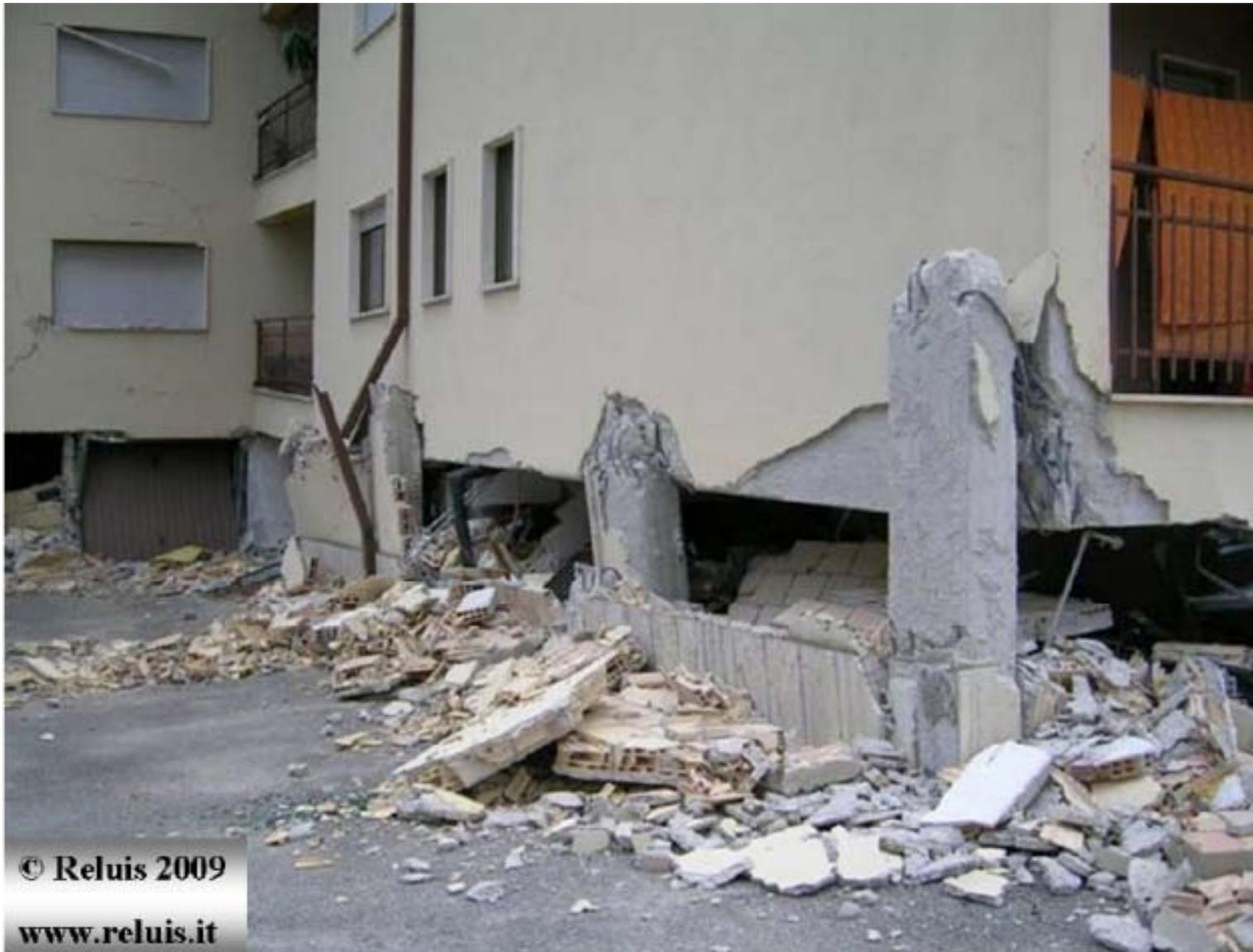
*Collasso strutturale con espulsione esterna dei pilastri in c.a. e schiacciamento del piano terra per il cedimento del nodo pilastro-trave non adeguatamente armato.*
