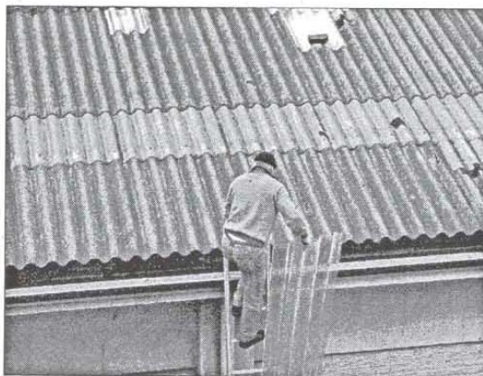
Un capannone con eternit
