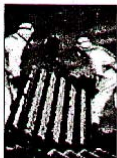
La rimozione di una lastra di amianto
