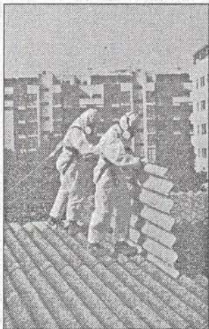
Bonifica dei pannelli di amianto presenti in molte strutture
