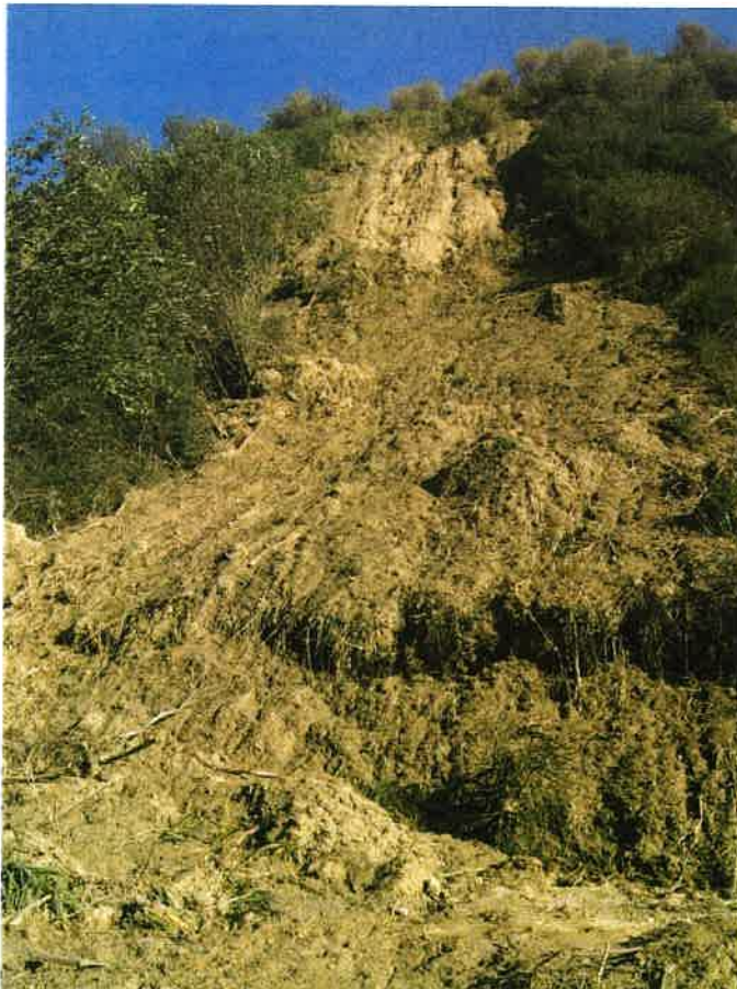
Foto 4 - B 3 AREA IMPLUVIO NORD
