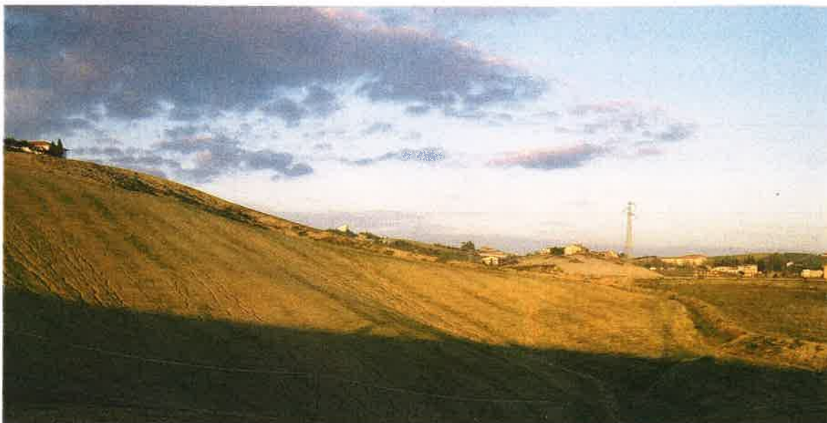
Foto 2 - Versante costituito da un complesso argilloso in cui sono evidenti i segni dei rigagnoli costituiti dall'erosione effettuata dalle piogge.
