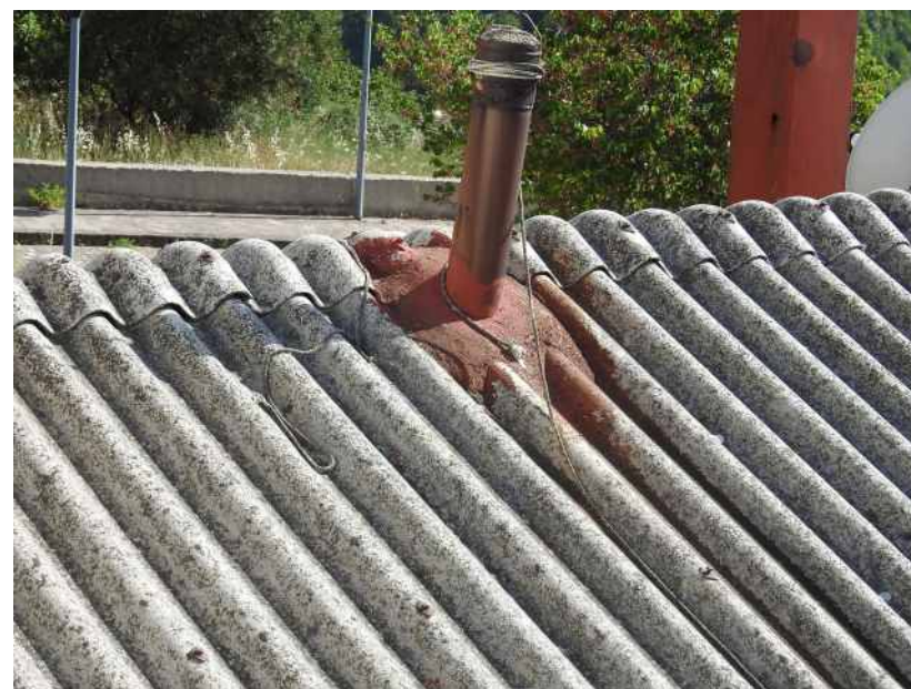
Foto N°8 - Particolare del colmo e del condotto di Foto N°4
