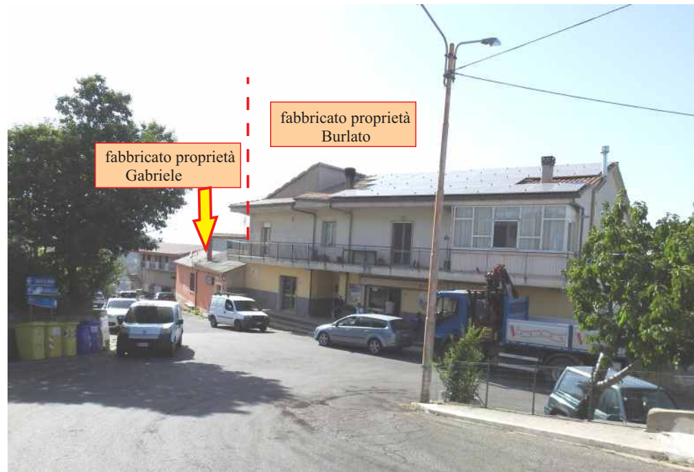
Foto N°1 - Vista frontale del fabbricato di proprietà Gabriele e di quello di proprietà Burlato, posti in aderenza
