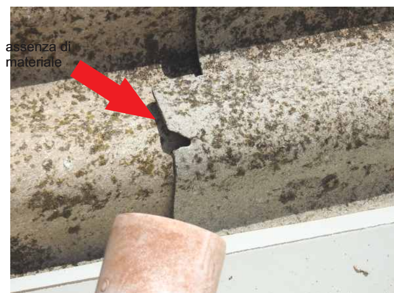
Foto N°13 - Vista ravvicinata di altra frattura e di segni di assenza di materiale per pregressa rottura
