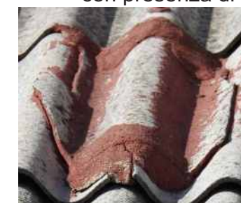
Foto N°15 - Particolare di un intervento di riparazione (foto N°5 e 7) con presenza di fratture e sovrapposizione di materiale
