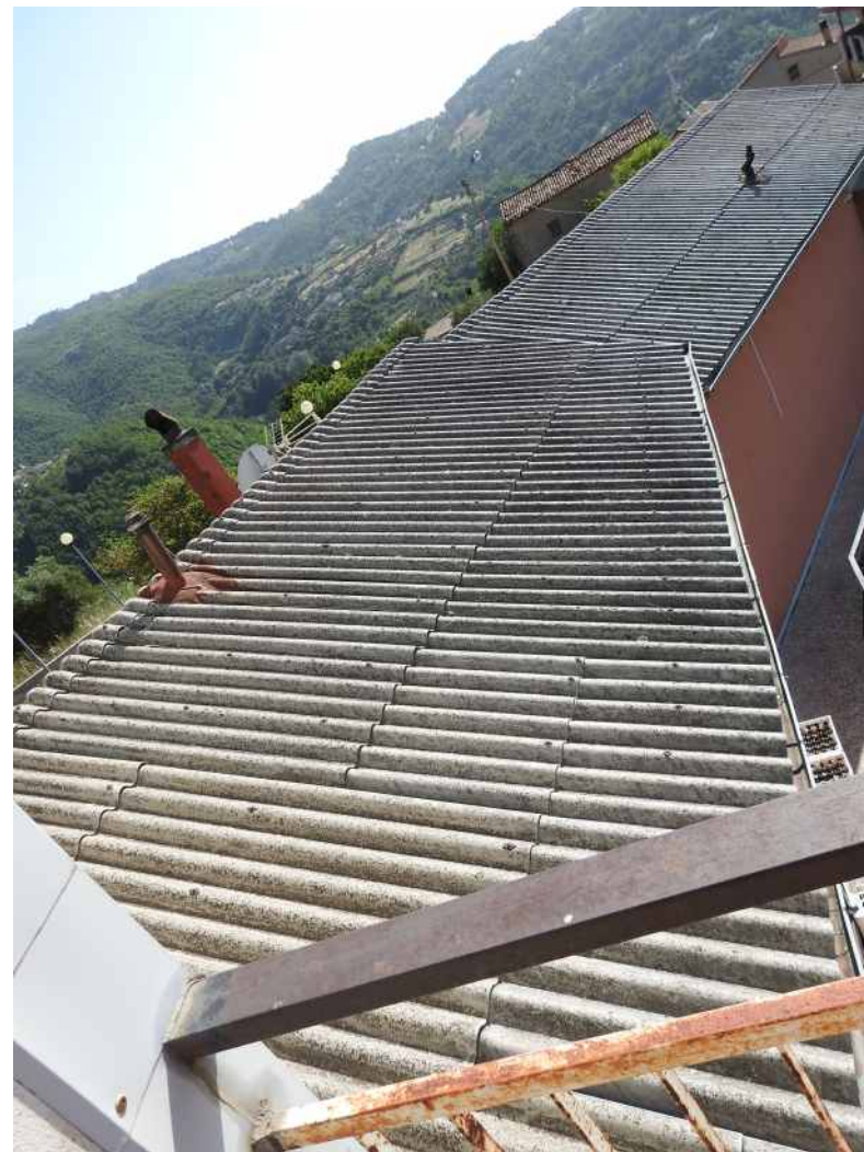
Foto N°4 - Falda di copertura lungo il fronte ovest
