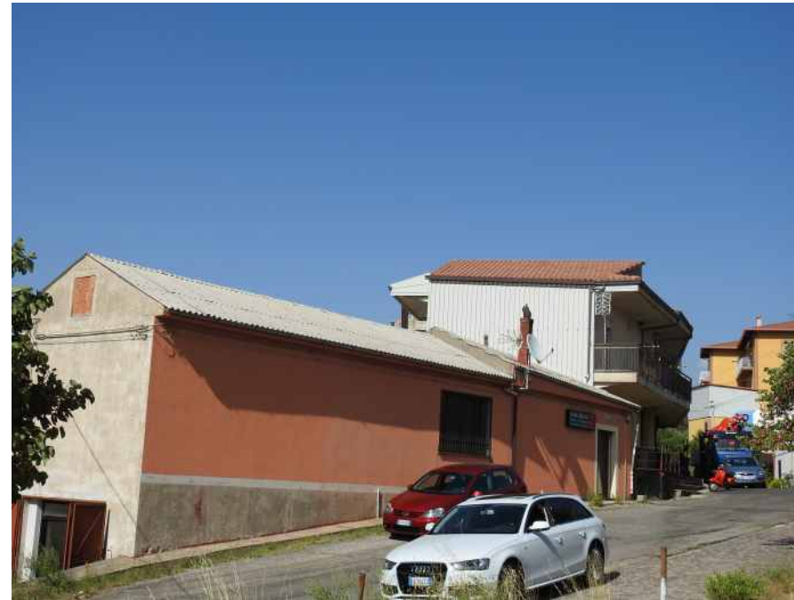
Foto N°2 - Vista del fabbricato con copertura in cemento amianto proprietà Gabriele (fronte est)
