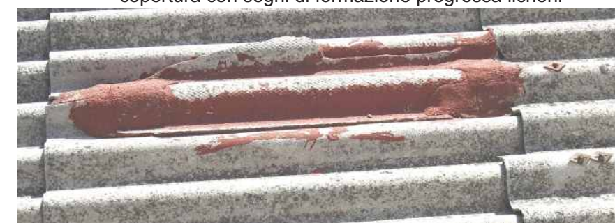
Foto N°15 - Particolare di un intervento di riparazione (foto N°5 e 7) con presenza di fratture e sovrapposizione di materiale
