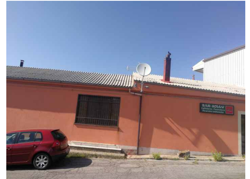
Foto N°3 - Altra vista frontale e ravvicinata del fabbricato interessato
