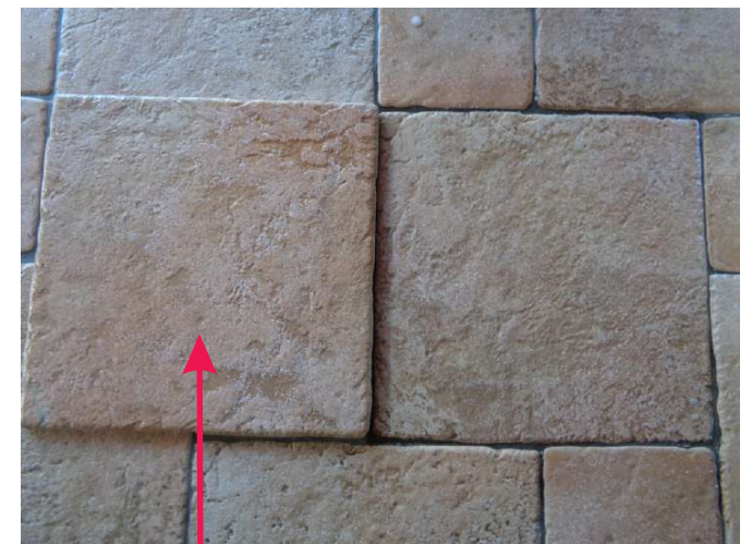
FOTO N°6: stesso raffronto della Foto N°4 dopo lavaggio
