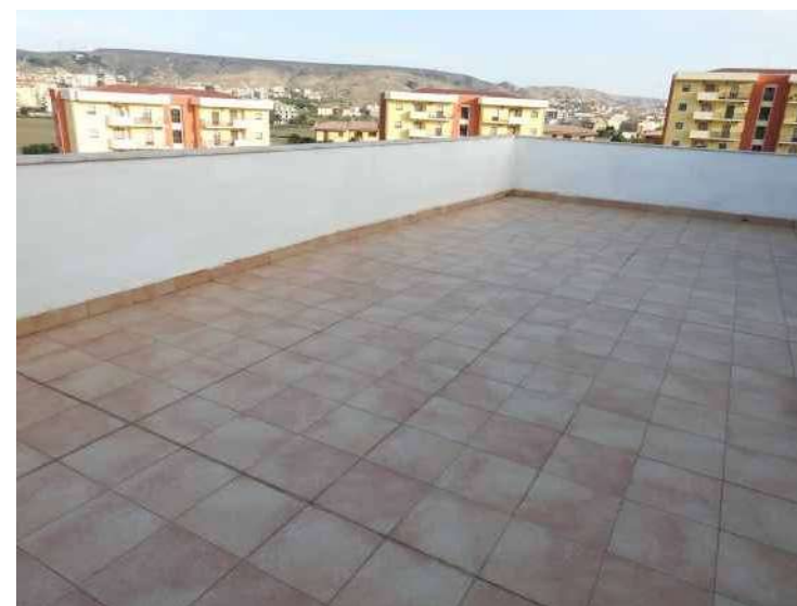
Foto N°35 - Pavimentazione del terrazzo soprastante la veranda di Foto N°33 e 34 (quinto piano)
