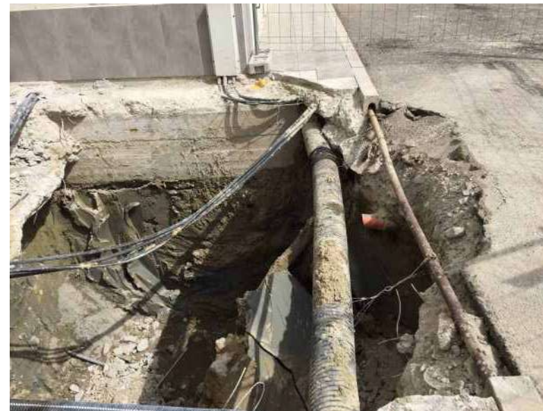
Foto N°41 - Foto relativa alla fase di sostituzione del serbatoio idrico interrato (2017). Si può notare che le travi fondali di collegamento dei plinti sono a contatto diretto le argille
