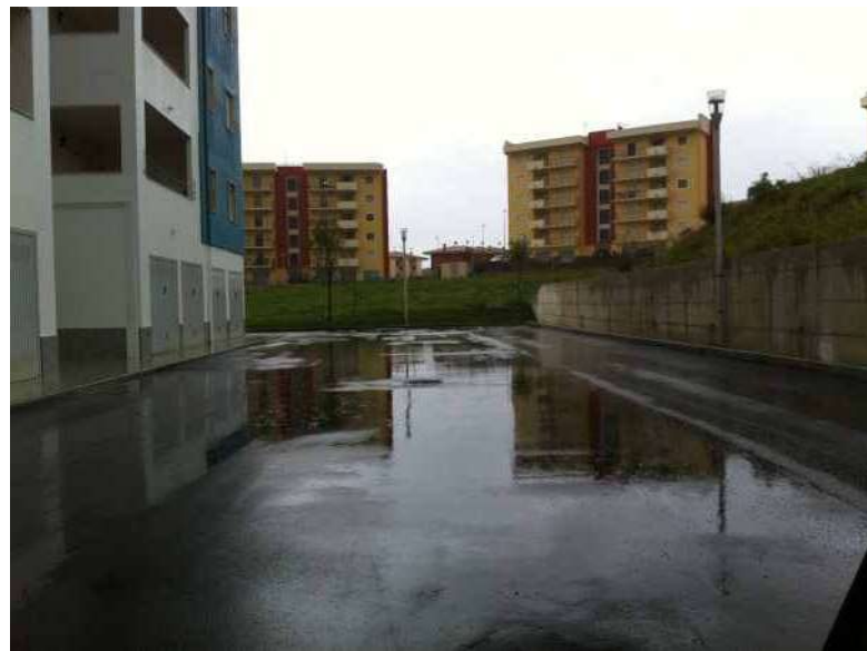
Foto N°37 - Vista del ristagno dell'acqua di precipitazione sul piazzale a monte del fabbricato (fronte Sud)
