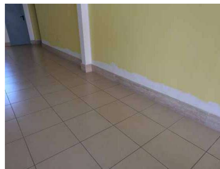
(PV14) Foto N°26 - Lavori di ripristino dell'intonaco sull'estremità inferiore delle pareti dell'androne, effettuati dall'impresa nell'anno 2017
