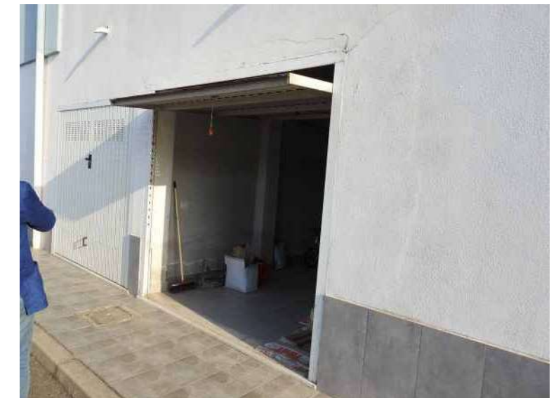
(PV8) Foto N°15 - Ingresso al box prop. sig. Spina
