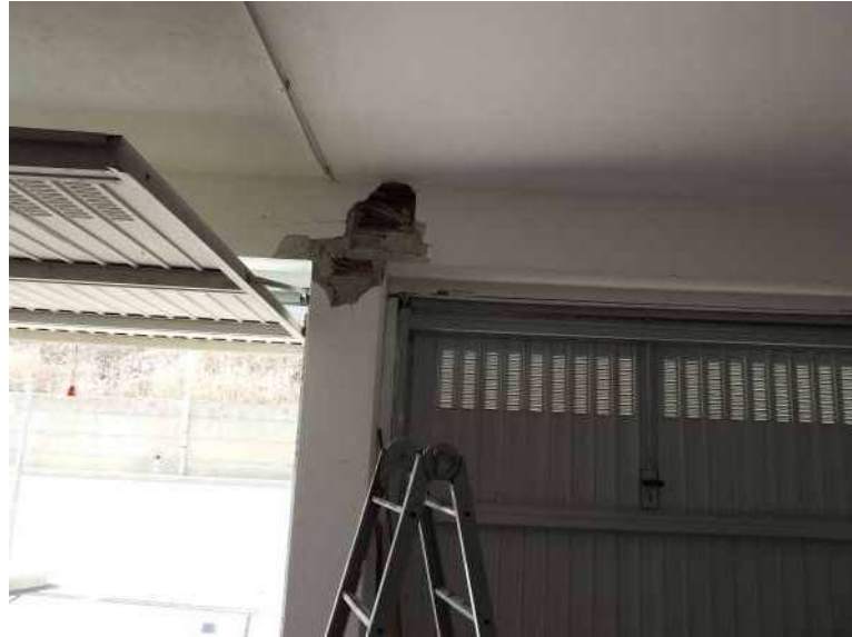
(PV6) Foto N°10 - Vista interna del box proprietà Masciopinto
