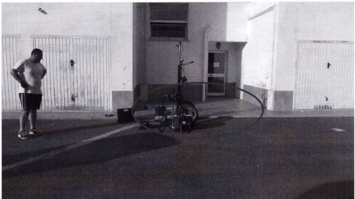
Fig.01: Area soggetta a cedimenti del marciapiede dovuto all'emungimento di acqua di raccolta scavo.
