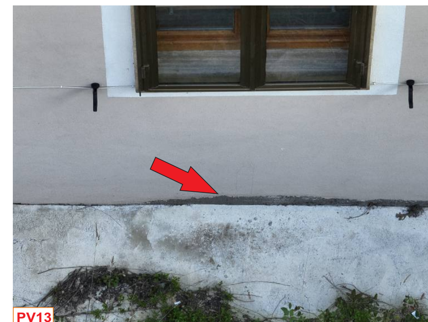
Foto N°42-Vista frontale ravvicinata raffigurante l'incompletezza della lavorazione cui alla foto n°40 ad andamento irregolare
