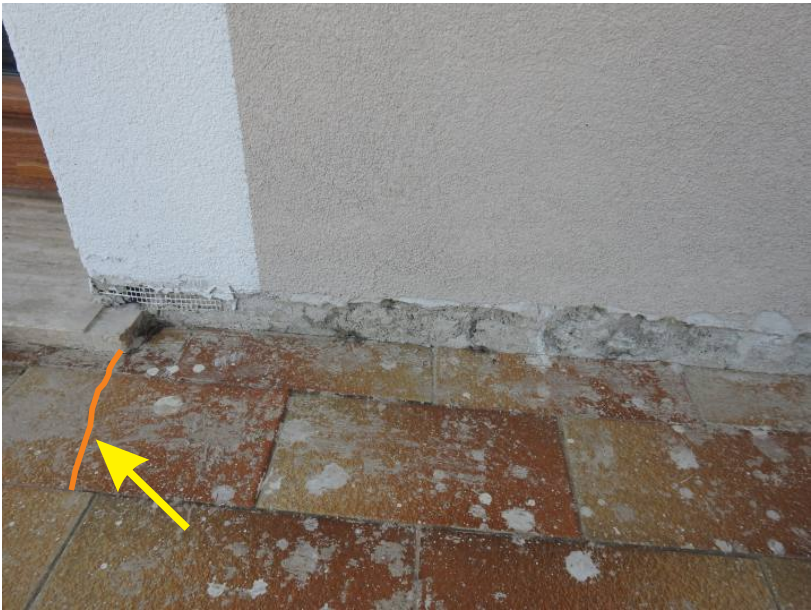
Foto N°25-Particolare della lesione 2 con vista dell'assenza della rasatura della parete lungo la linea di contatto con il pavimento
