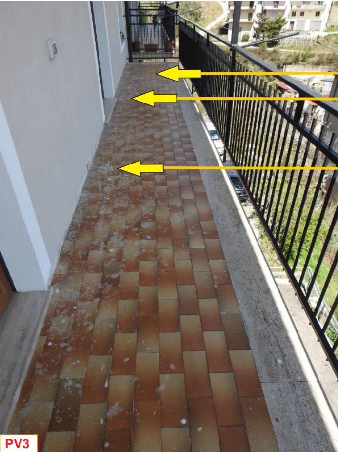
Foto N°23 - Vista da Sud verso Nord del balcone con indicazione della posizione delle lesioni a carico del pavimento. Si può notare altresì, la presenza a tutt'oggi di residui di materiale rasante riconducibile ai lavori eseguiti sulla parete ed all'intradosso della pensilina/balcone
