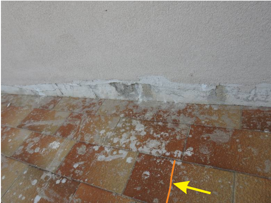
Foto N°26-Particolare della lesione 3 e dell'incompletezza della rasatura della parete lungo la linea di contatto con il pavimento. Si tratta di una condizione che, evidentemente, implica la successiva posa dei battiscopa
