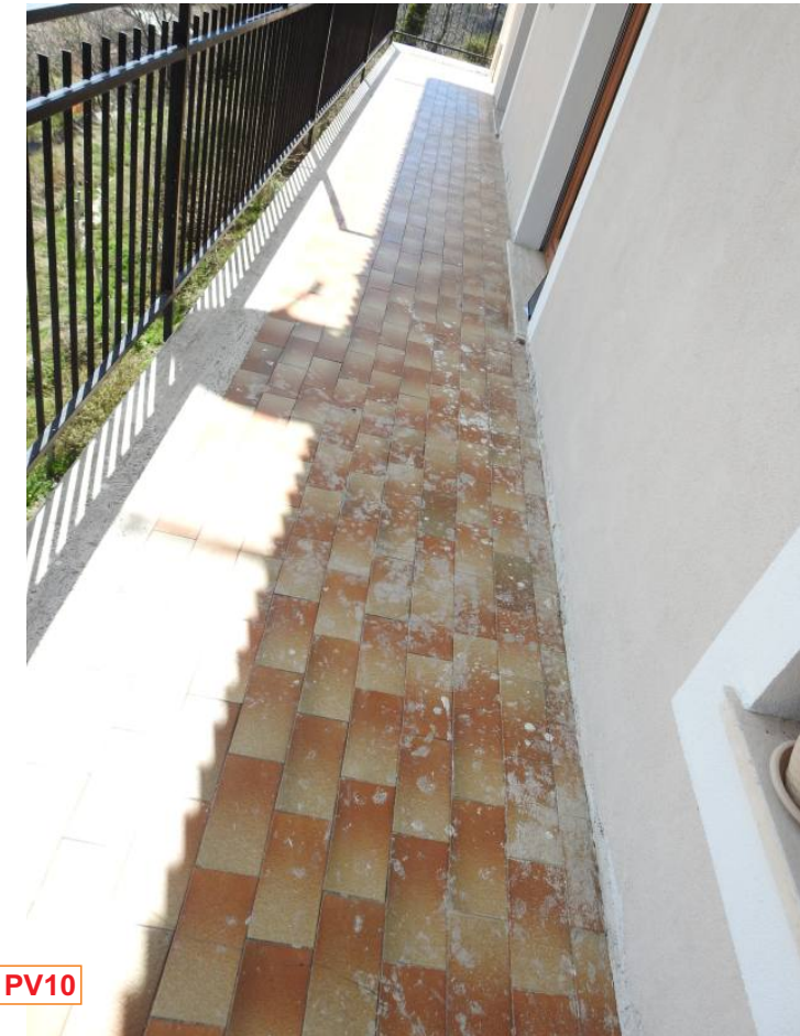
Foto N°28 - Il balcone visto nella direzione da Nord verso Sud. Come nella Foto N°23 si evidenzia la presenza diffusa di materiale di risulta (rasante) delle lavorazioni eseguite
