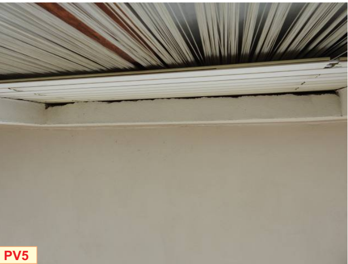
Foto N°19 - Irregolarità della finitura dell'architrave della prima porta finestra che apre sul balcone (vista dal basso verso l'alto)
