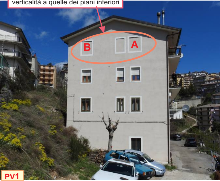
Foto N°10 - Prospetto sud con indicazione delle presunte dissimmetrie dei riquadri delle finestre del 3° piano
