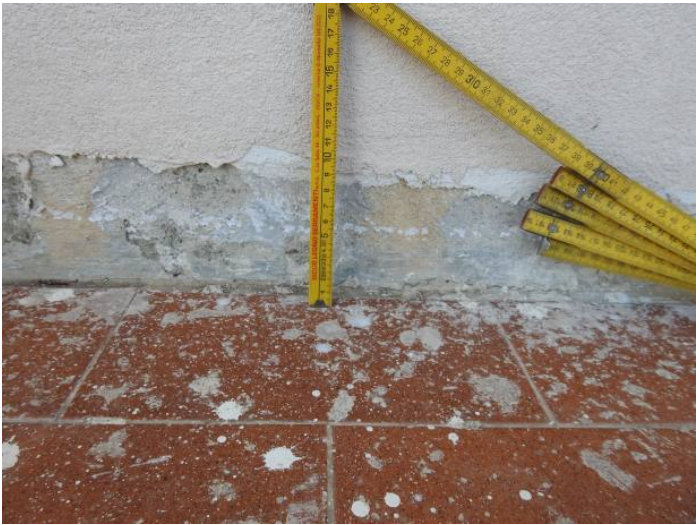
Foto N°17 - L'applicazione della rasatura si ferma a circa 10 cm dal pavimento del balcone, condizione da cui si presume la successiva applicazione dei battiscopa
