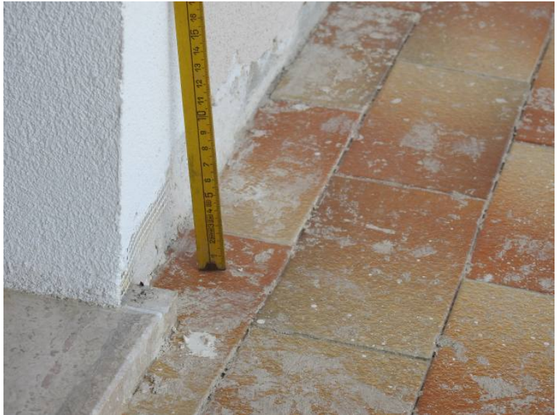
Foto N°27-Stima dell'altezza della parte di parete priva di rasatura lungo la linea di contatto con il pavimento (cm 10 circa)
