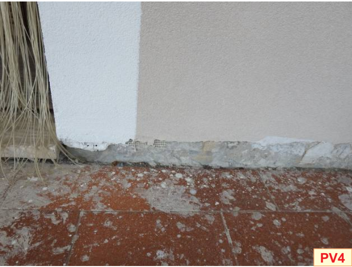
Foto N°16 - Stato della rasatura della parete nel punto di contatto con la pavimentazione del balcone
