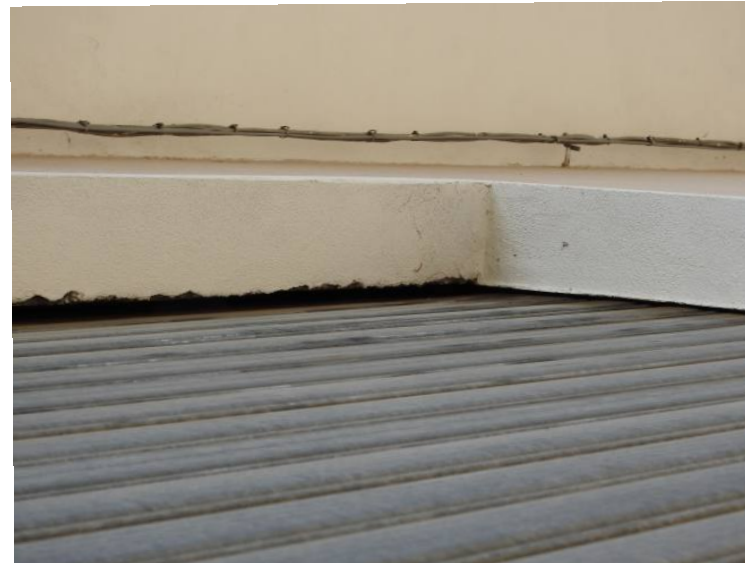
Foto N°35-Particolare della non corretta finitura dello spigolo dell'architrave di cui alla foto n°34 al pari di quelle delle Foto N°19 e 21
