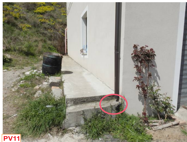
Foto N°38-Linea di contatto parete-marciapiedi di cui alla Foto N°37. Al momento del sopralluogo era assente la curva terminale del discendente nel punto indicato
