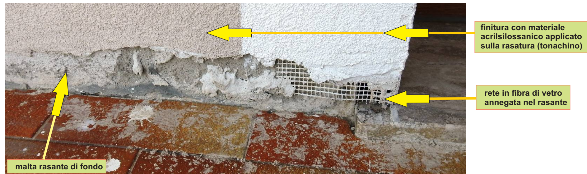
Foto N°32 - Particolare esecutivo della rasatura e finitura delle pareti esterne: si può notare la rete rinforzante in fibra di vetro annegata nel rasante ed il soprastante strato di finitura con tonachino premiscelato del tipo acrisilossanico
