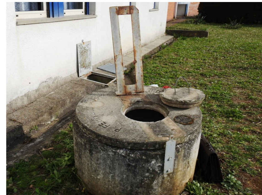
FOTO N°3 - Particolare del pozzo della Foto N°2
