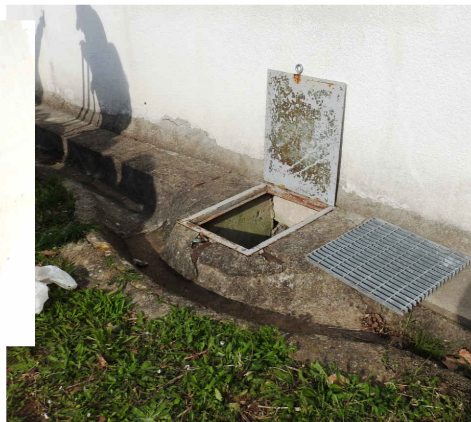
FOTO N°5 - Particolare del pozzetto e della griglia rimossa per accedere nella intercapedine fondale
