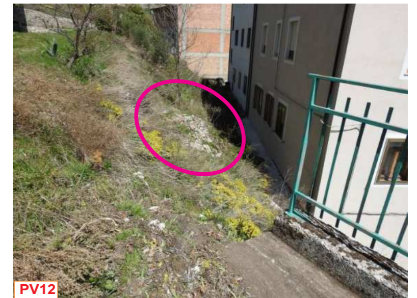
Foto N°44 - Altra indicazione del cumulo di rifiuti di cui alla Foto N°44
