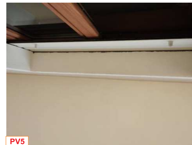
Foto N°30 - Finitura dello spigolo dell'architrave della porta-finestra lato sud con la quale si accede al balcone. Dal confronto con le Foto N°21 e 21 del 2° piano si rileva, in questo caso, una migliore ed accettabile esecuzione
