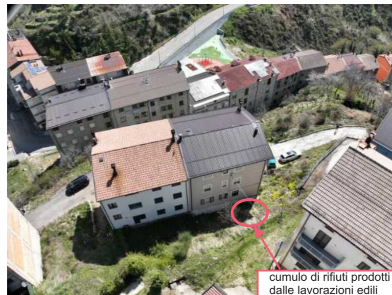
Foto N°8 - Fronte ovest il cui piano terra, in parte seminterrato, è a contatto con la retrostante scarpata
