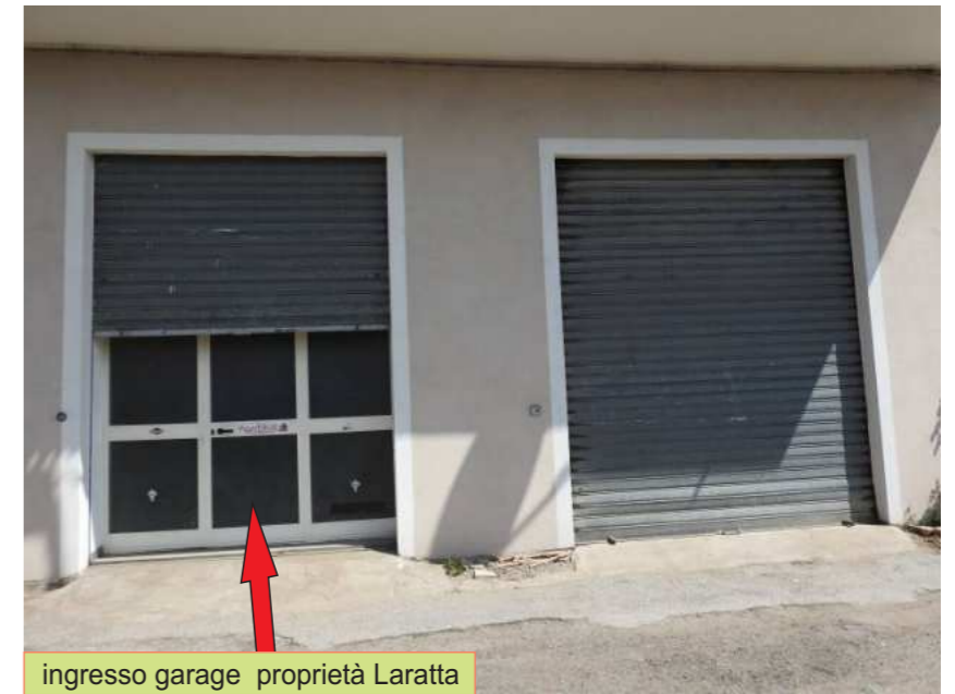
Foto N°33 - Piano terra, fronte esterno del garage
