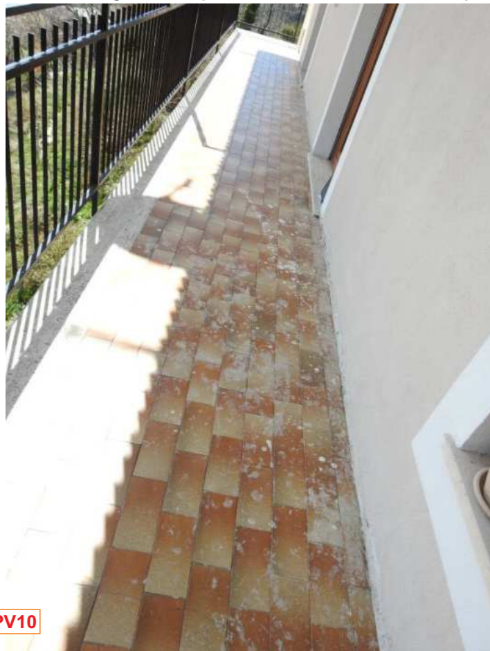
Foto N°28 - Il balcone visto nella direzione da Nord verso Sud. Come nella Foto N°23 si evidenzia la presenza diffusa di materiale di risulta (rasante) delle lavorazioni eseguite
