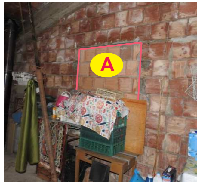
Foto N°11 - Lato interno della parete della soffitta (3°P) con indicazione del riquadro del vano finestra, allo stato murato, cui corrisponde il riquadro in tinta bianca della Foto N°10
