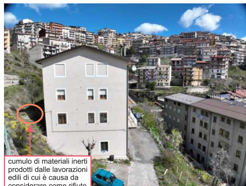
Foto N°7 - Prospetto sud con indicazione del cumulo di macerie edili esistenti lungo il terrapieno (fronte ovest)
