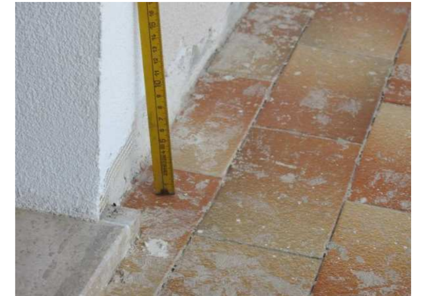
Foto N°27 - Stima dell'altezza della parte di parete priva di rasatura lungo la linea di contatto con il pavimento (cm 10 circa)
