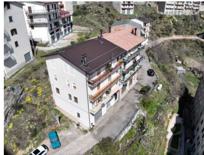
Foto N°2 - Prospetti sud - est lungo la via IV Luglio
