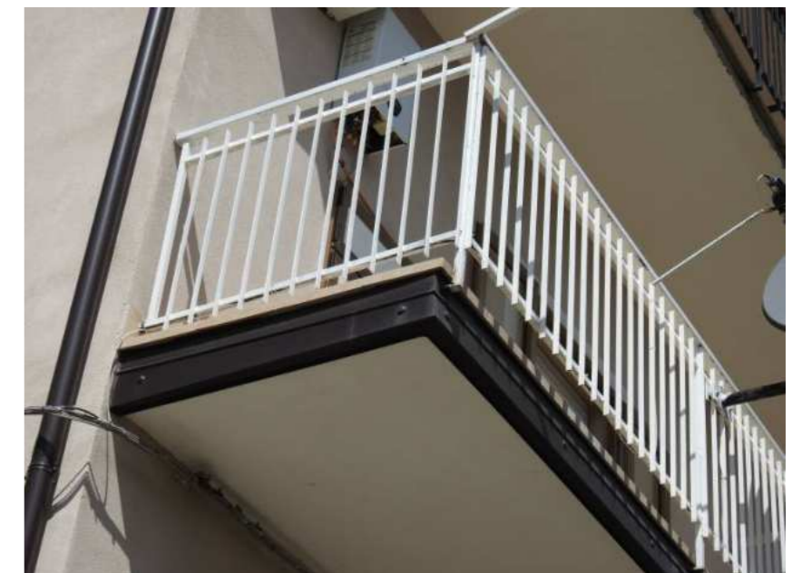
Foto N°47 - Vista dal basso dell'intradosso del balcone del primo piano di cui alla Foto N°46 e del frontale rivestito con scossalina in lamiera dopo i lavori di ripristino
