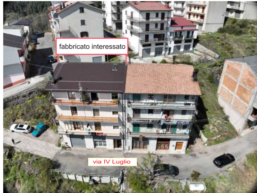
Foto N°1 - Prospetto principale (fronte est)
