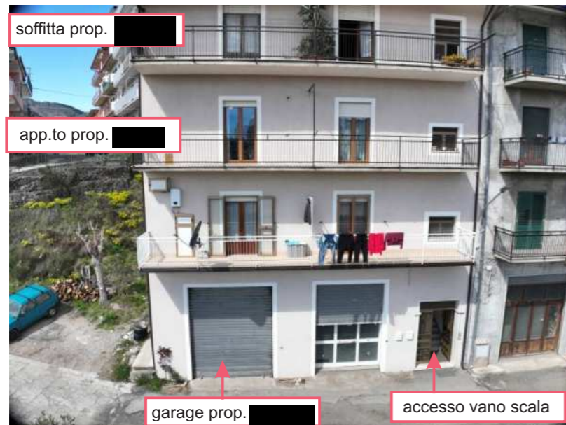
Foto N°4 - Vista ravvicinata del prospetto principale e dei balconi
