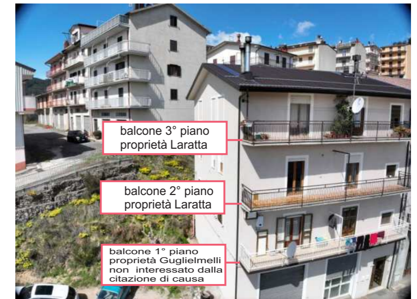
Foto N°3 - Vista dei balconi di tutti i piani del fabbricato
