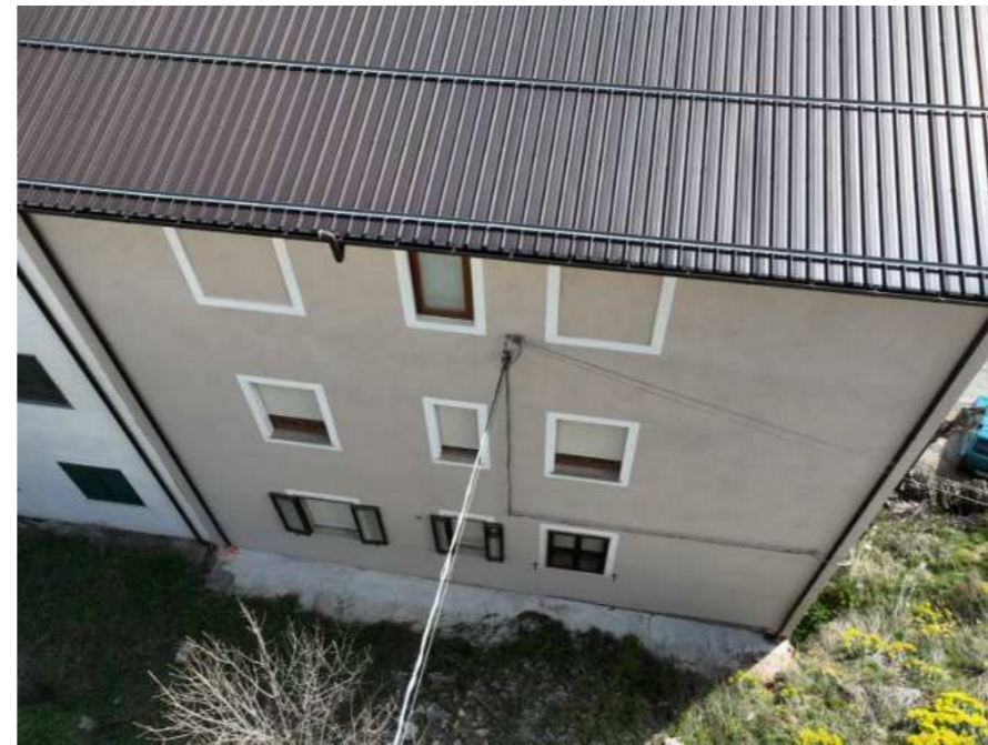
Foto N°41 - Vista da drone del fronte posteriore del fabbricato
