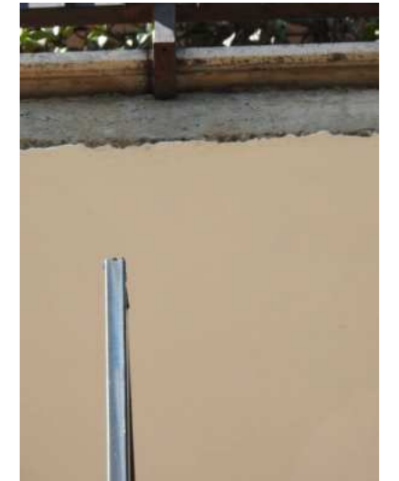
Foto N°18 - Il frontale del balcone
