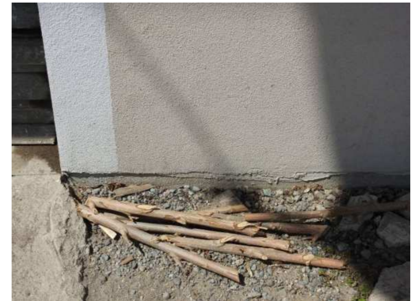
Foto N°36 - Finitura superficiale della parte inferiore della parete di cui alla precedente Foto N°33
