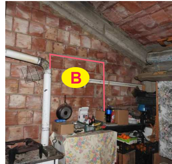
Foto N°12 - Altro lato interno della parete della soffitta (3°P) con indicazione del riquadro del vano finestra, allo stato, murato
