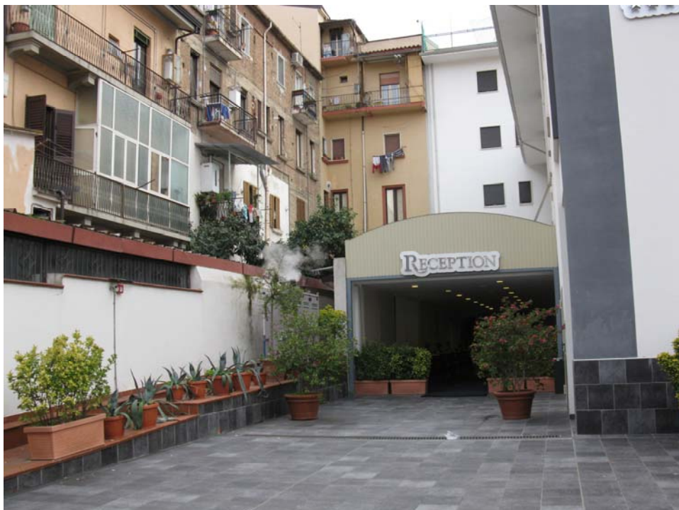
P.V.1 – FOTO N°2: Ingresso
