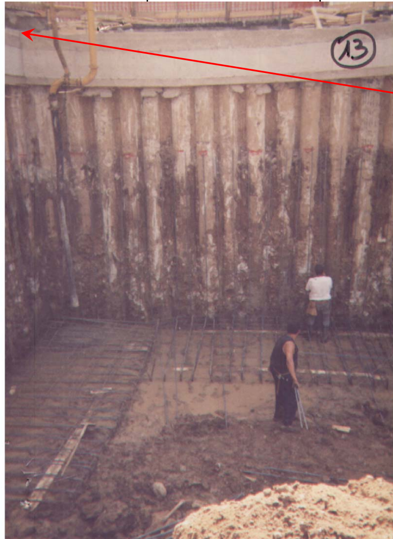
FOTO N°13AT: vista dell'armatura del muro di sostegno (fondazione ed elevazione) in corrispondenza dello scavo nei pressi del fabbricato esistente
