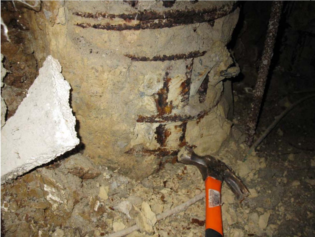
P.V.9– FOTO N°13: Il calcestruzzo dello strato superiore, rimosso con la sola azione del martello, rimane legato ad esso per la presenza di umidità nel materiale stesso. Infatti la parte rimossa è umida al tatto, circostanza questa che conferma quanto sostenuto dal geologo a riguardo della circolazione idrica superficiale
