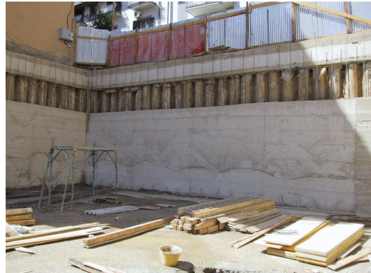
FOTO N°8AC: vista del muro ultimato, addossato alla paratia, in corrispondenza del fabbricato esistente (punto di vista comparabile a quello delle foto 13AT) (N.B.: il muro rappresentato nelle foto 1AC e 2AC è colorato in rosso in All. N°3-Tav. N°3)
