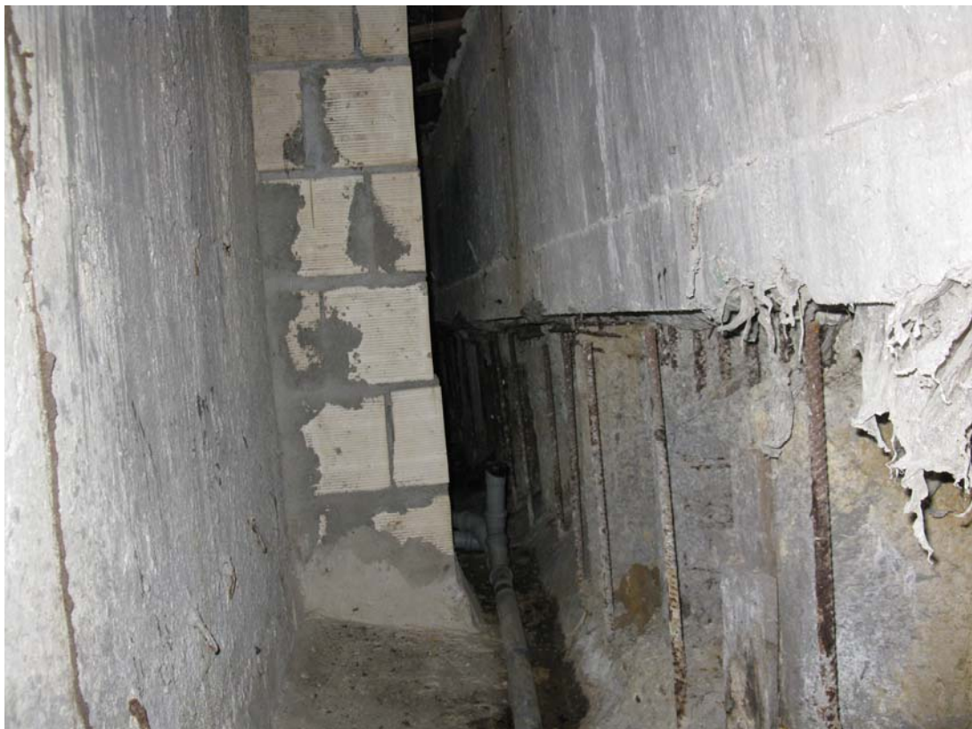
P.V.9– FOTO N°12: Lo stato e la consistenza del calcestruzzo in questi altri pali conferma quanto già commentato per la Foto N°9
