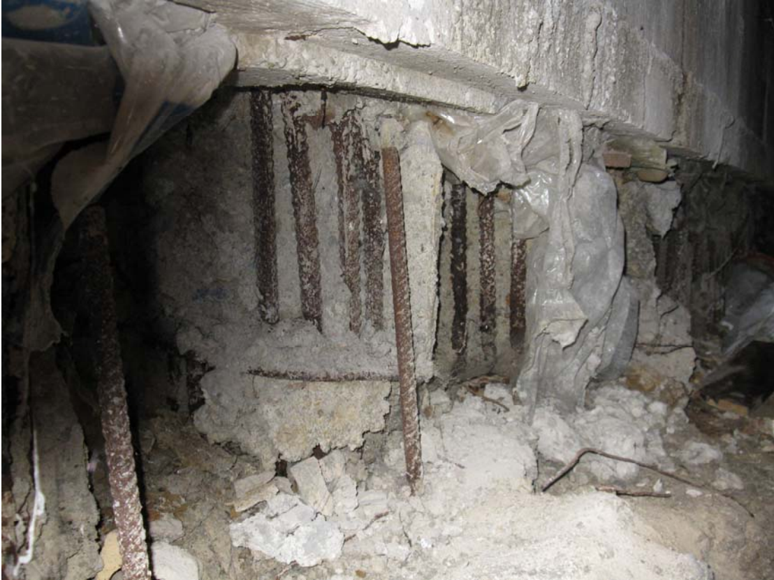
P.V.9– FOTO N°15: Vista ravvicinata dello stato del calcestruzzo e dell'armatura in altri pali. Come nelle foto precedenti, si rileva l'assenza del copriferro, l'irregolarità strutturale e la disomogeneità del calcestruzzo
