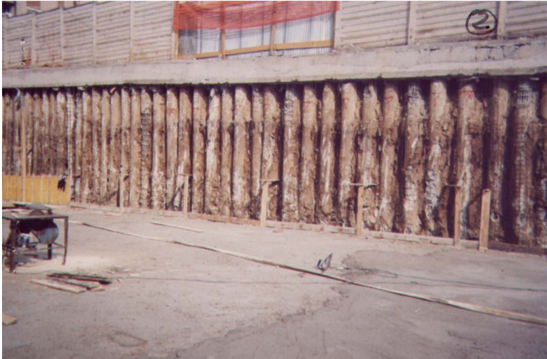
FOTO N°3AT: Preparazione della carpenteria per la realizzazione del muro di altezza modesta (cm 120) lungo il fronte nord della paratia, estremità inferiore (confr. All. N°3-Tav. N°3). Non si evidenziano ferri di attesa sul piano di appoggio del muro. Si può apprezzare l'irregolarità generalizzata del calcestruzzo dei pali.
