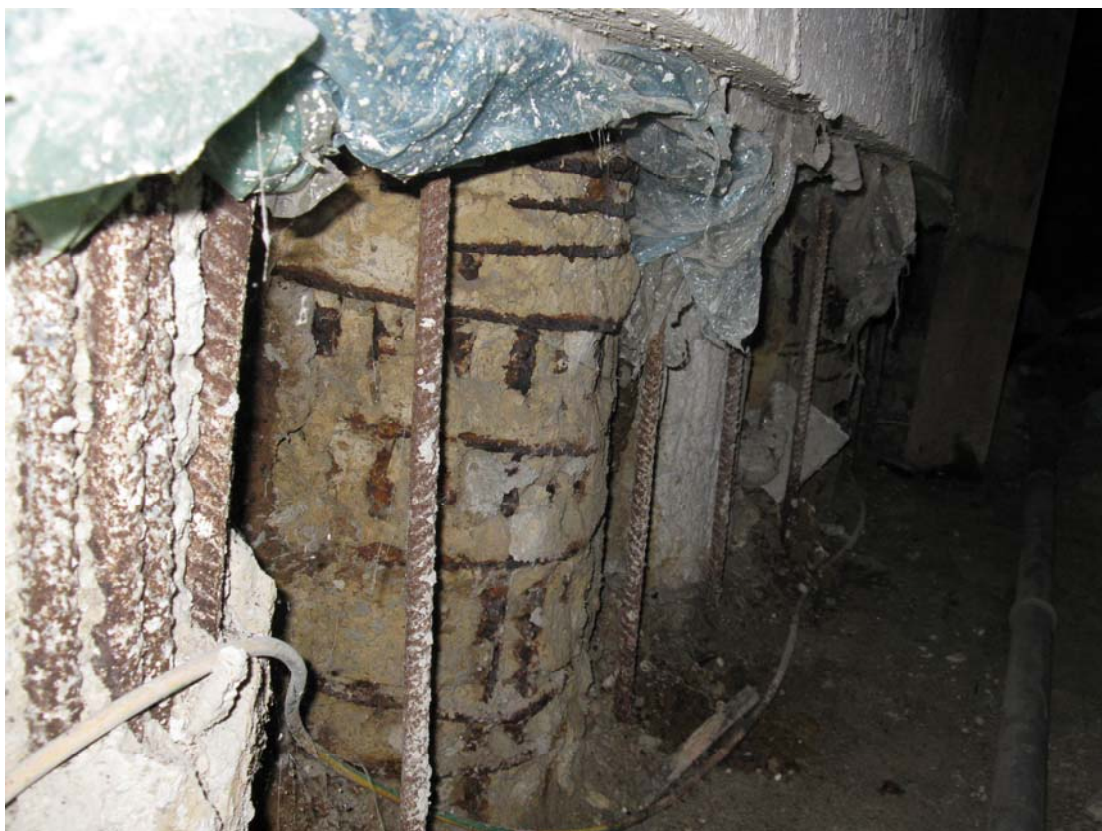
P.V.9– FOTO N°12: Lo stato e la consistenza del calcestruzzo in questi altri pali conferma quanto già commentato per la Foto N°9
