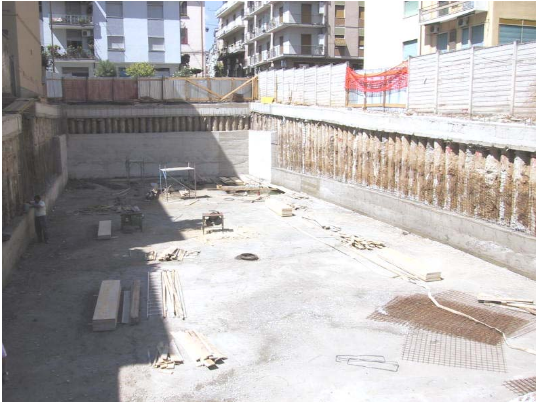
FOTO N°8AC: Particolare del muro di maggiore altezza in corrispondenza del fabbricato esistente
