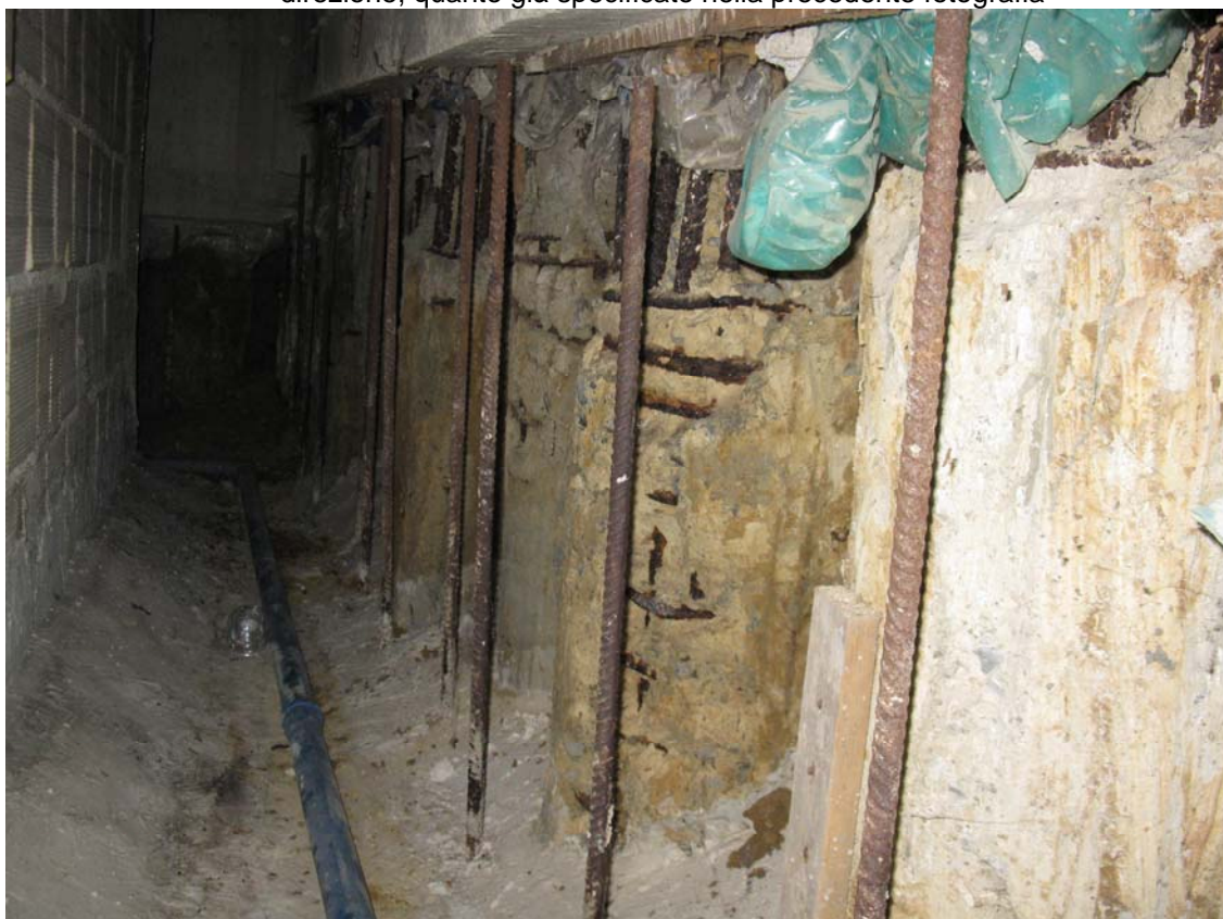
P.V.7– FOTO N°8: Estremità superiore di alcuni pali. Si osserva, anche lungo questa direzione, quanto già specificato nella precedente fotografia
