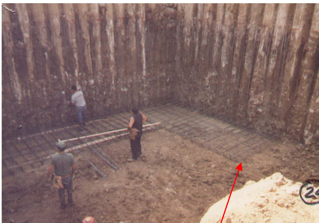
FOTO N°24AT: Vista dell'armatura del muro di sostegno di maggiore altezza in fase di lavorazione lungo la paratia che fa angolo con via L. M. Greco.
