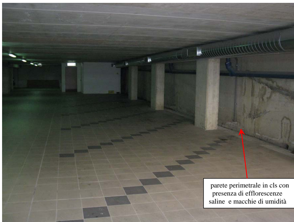
P.V.3 – FOTO N°4: Interno piano interrato, vista della parete perimetrale addossata alla paratia, riconducibile a quella già indicata in Foto N°5AC (foto acquisite)
