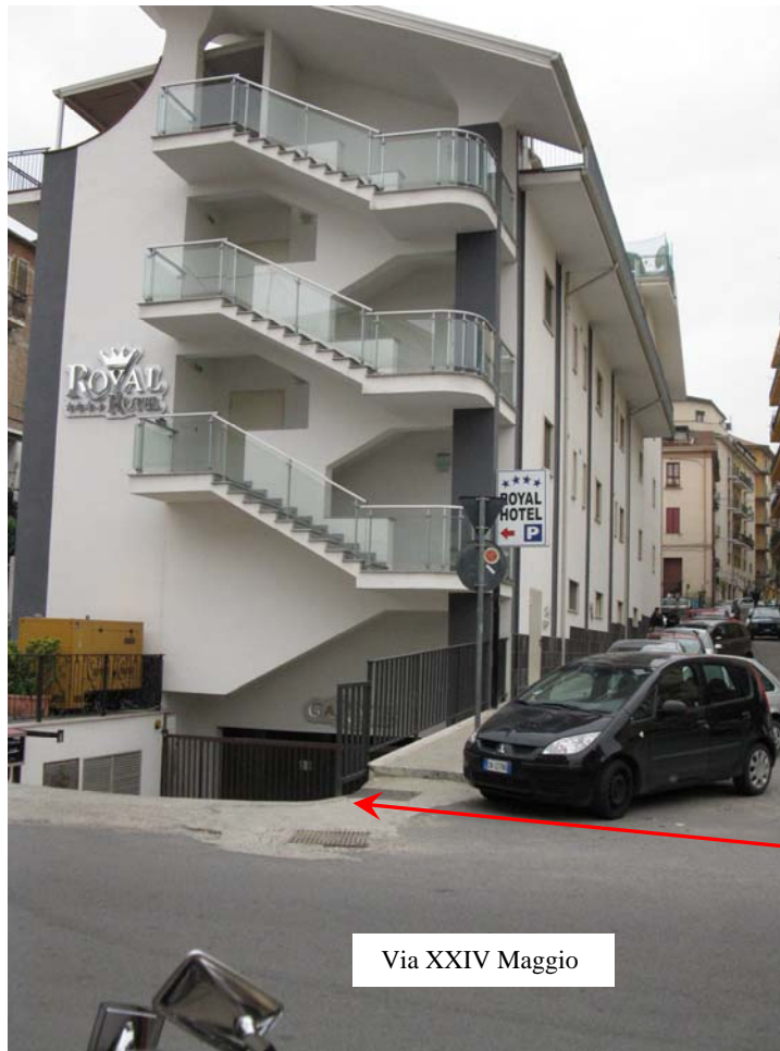
P.V.1 – FOTO N°1: Fronte anteriore
