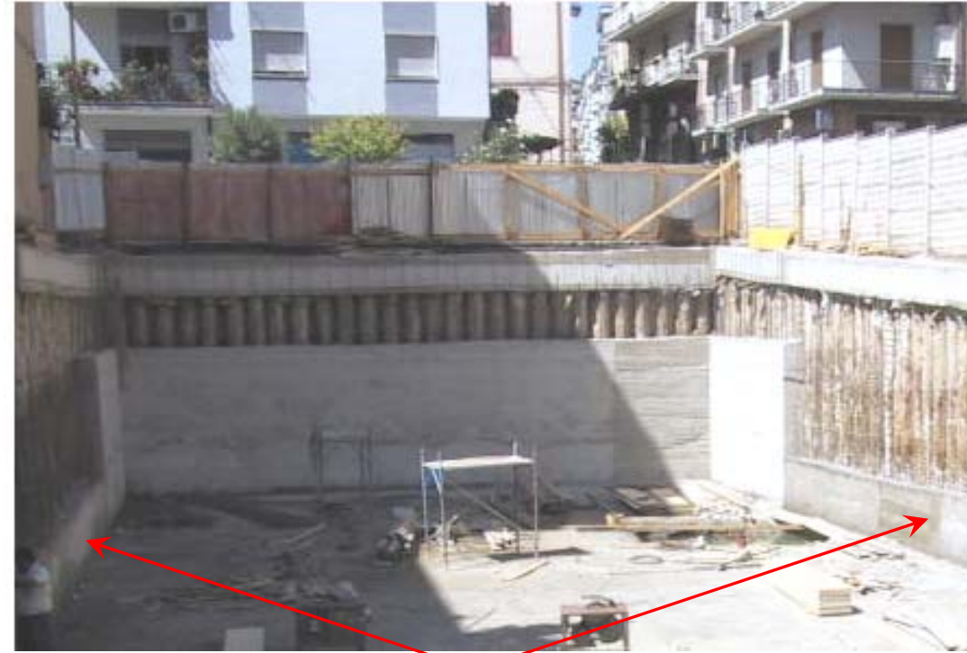
FOTO N°7AC: vista panoramica del muro ultimato, addossato alla paratia, formante una "U" (punto di vista comparabile a quello della foto 25AT)
