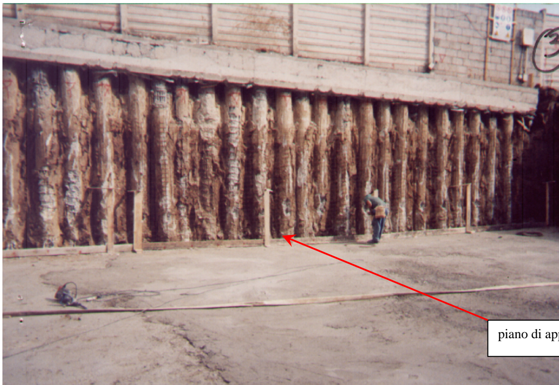
FOTO N°3AT: Preparazione della carpenteria per la realizzazione del muro di altezza modesta (cm 120) lungo il fronte nord della paratia, estremità inferiore (confr. All. N°3-Tav. N°3). Non si evidenziano ferri di attesa sul piano di appoggio del muro. Si può apprezzare l'irregolarità generalizzata del calcestruzzo dei pali.
