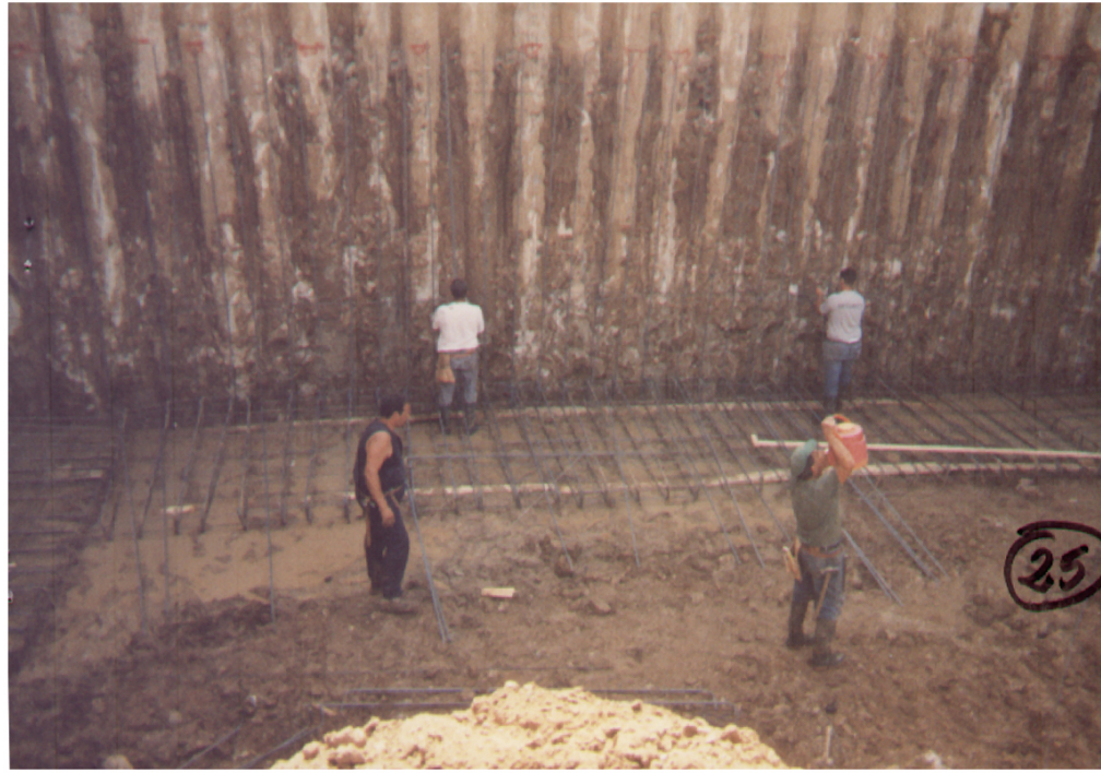
FOTO N°13AT: vista dell'armatura del muro di sostegno (fondazione ed elevazione) in corrispondenza dello scavo nei pressi del fabbricato esistente
