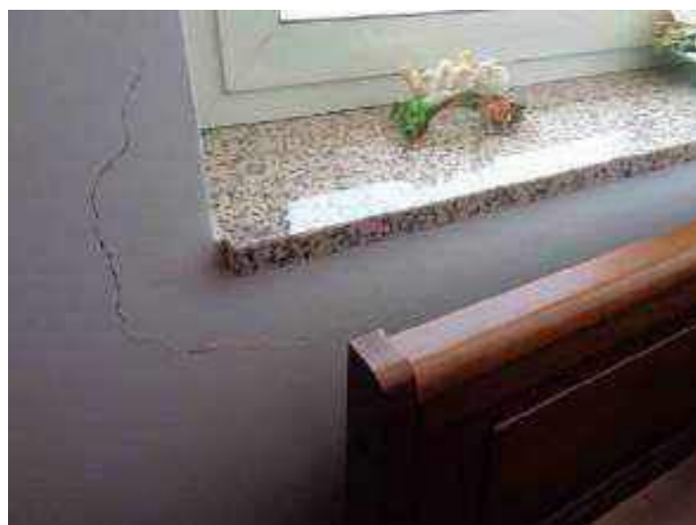
Foto 3M - Lesione in corrispondenza della finestra (cucina)
