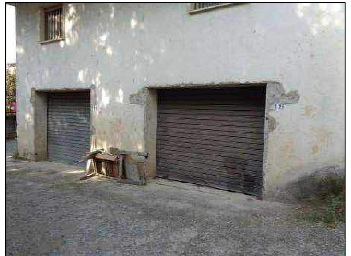
Foto 1A - Vista dei due accessi carrabili del seminterrato (fronte est)
