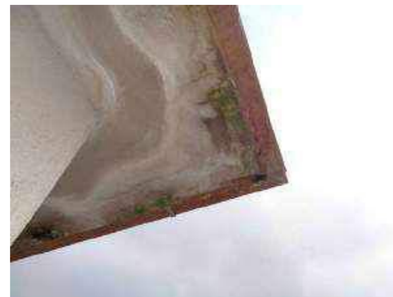
Foto 6Q - Stato di avanzato degrado materico della pensilina di copertura e della gronda (presenza di muschi)
