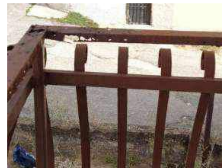
Foto 3O - Stato di avanzata corrosione della ringhiera
