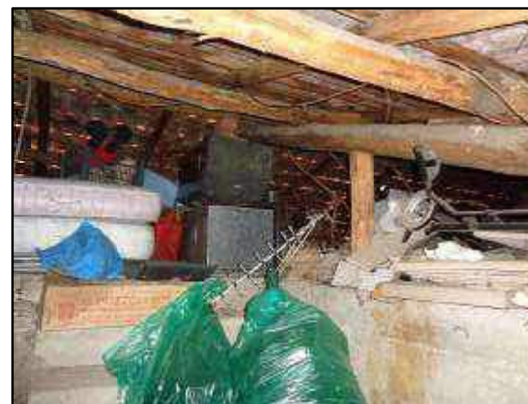
Foto 8B - Vista dei sostegni applicati alle travi portanti
