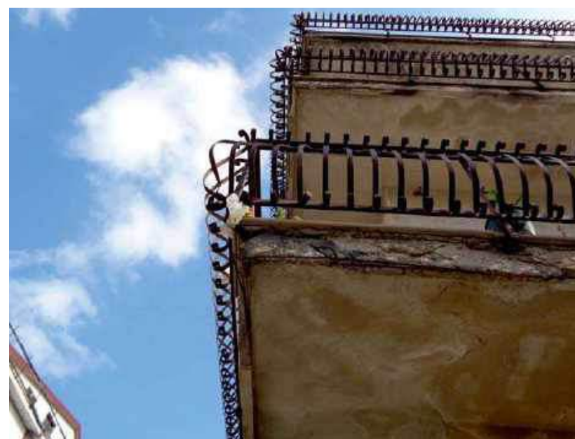
Foto N°8 - Il dissesto dei balconi situati intorno all'angolo sud - ovest del fabbricato
