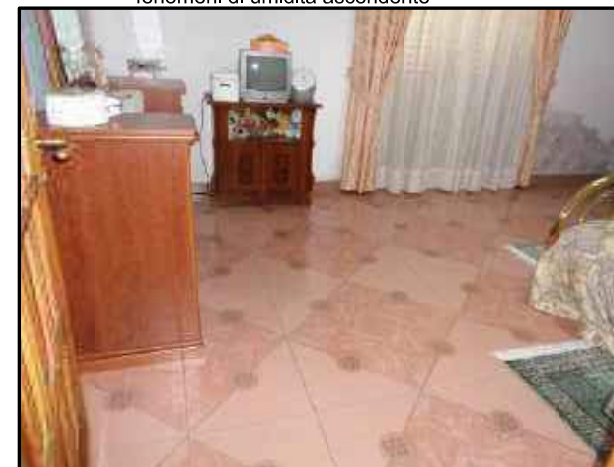
Foto 3C - Camera da letto con parete esterna interessata da fenomeni di umidità ascendente
