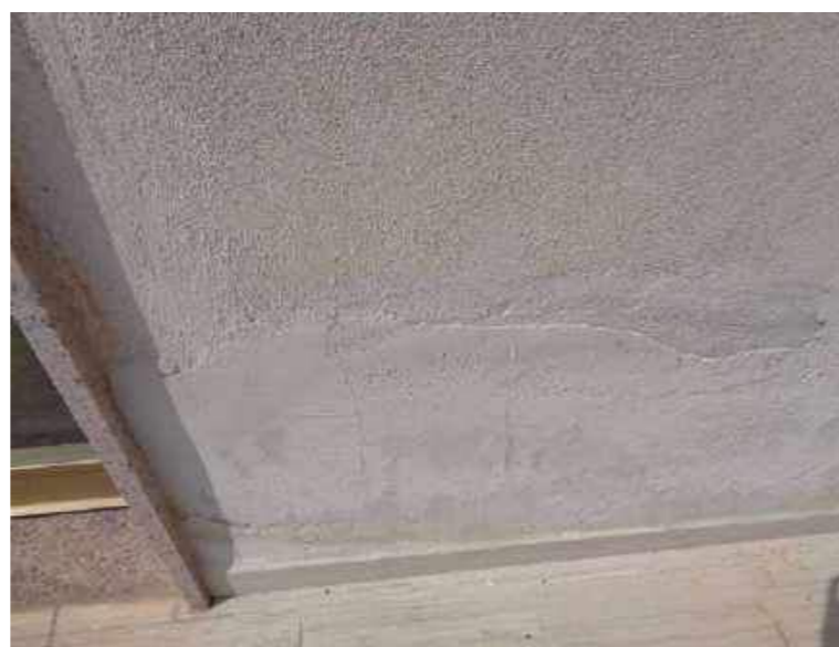
Foto 6P - Altre parti di intonaco esterno ripristinato
