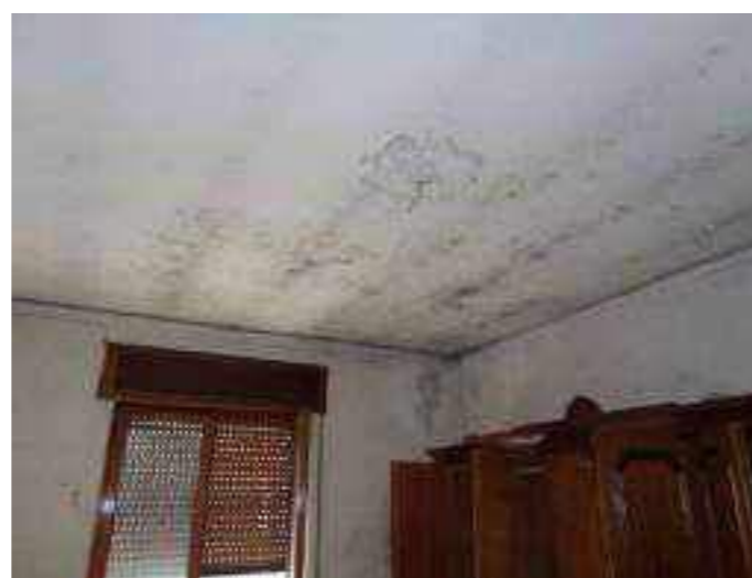
Foto 11H - Umidità da infiltrazioni nel bagno
