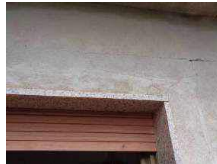
Foto 6N - Ammadoramento materico della pensilina di copertura, della gronda e lesioni lungo la muratura che delimita l'apertura sul balcone
