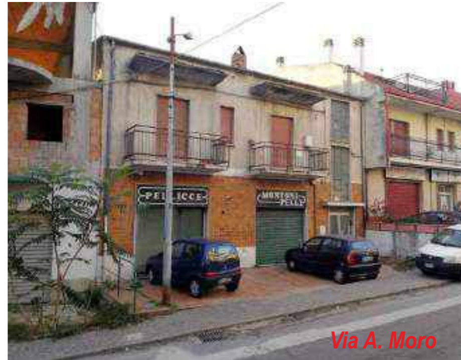
Foto N°11- Fabbricato indicato nella foto precedente ritratta dalla Via A. Moro
