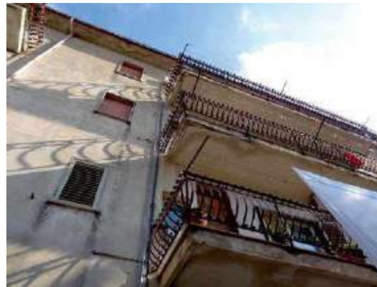
Foto N°8 - Il dissesto dei balconi situati intorno all'angolo sud - ovest del fabbricato
