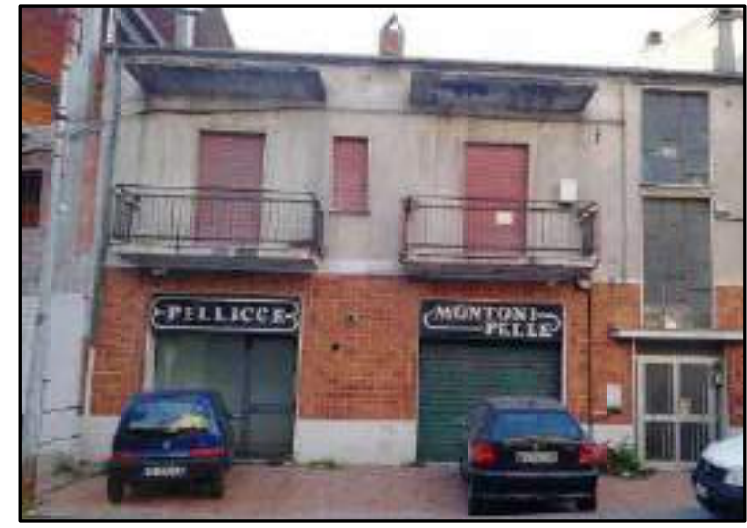
Foto 10A - Vista del prospetto est, fronte principale, con gli accessi al locale
