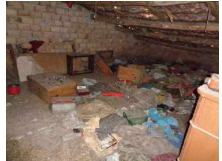
Foto 11N - Vista di un altro spazio della soffitta
