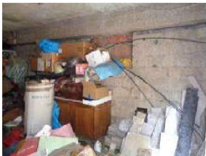
Foto 1E – Particolare della parete posta a dx nella Foto 1B (fronte nord)
