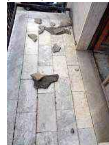
Foto 11I - Il pavimento del balcone, in stato di degrado, su cui cadono i pezzi di intonaco che si distaccano dalla soprastante pensilina
