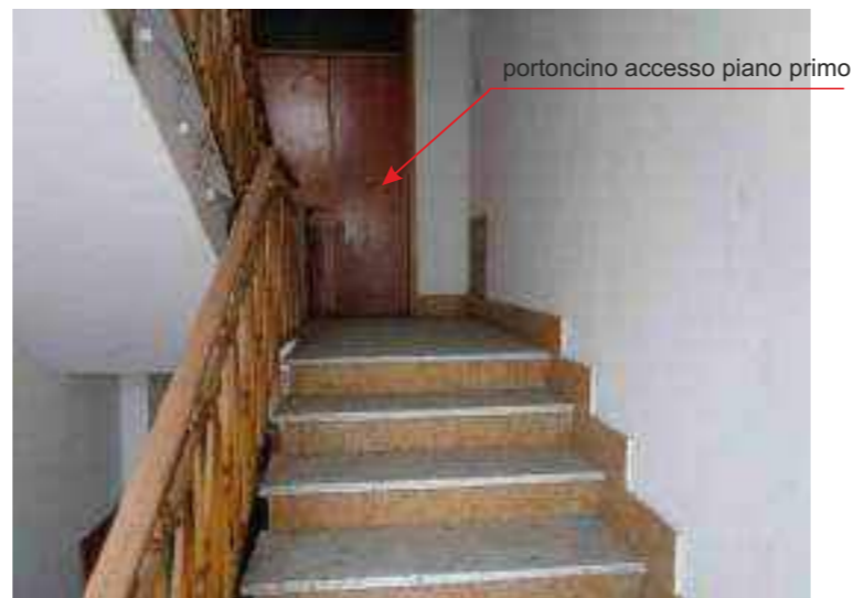
Foto 11B - L'interno del vano scala che conduce al piano primo, alla soffitta ed al piano seminterrato
