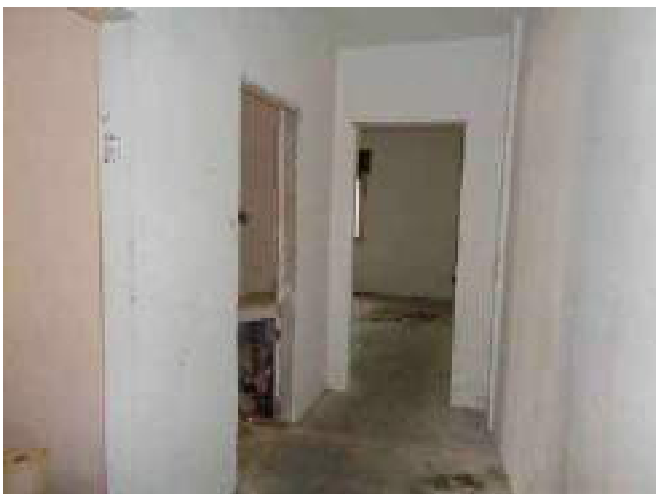
Foto 2F – Vista dei nuovi ambienti in corso di realizzazione
