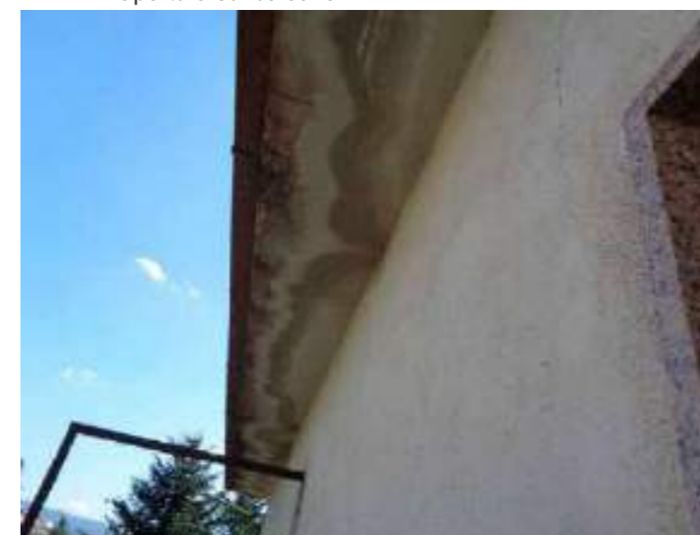
Foto 6Q - Stato di avanzato degrado materico della pensilina di copertura e della gronda (presenza di muschi)
