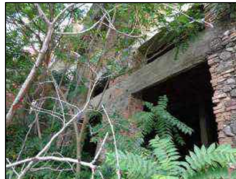
Foto 9C - Vista ravvicinata della muratura portante
