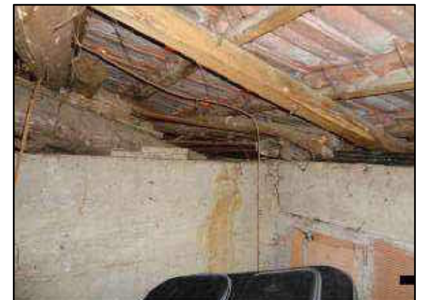
Foto 8C - Particolare dello stato della trave di colmo
