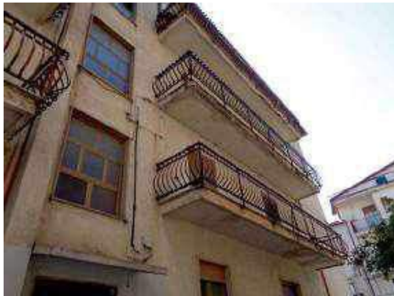
Foto N°7 - Particolare dell'avanzato stato di dissesto dei balconi (primo piano, angolo nord - ovest)
