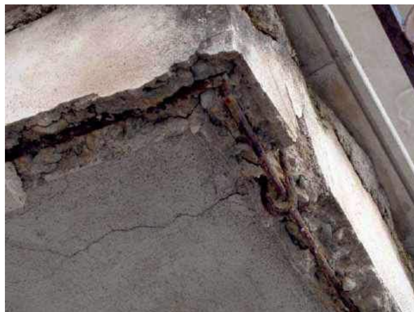
Foto N°7 - Particolare dell'avanzato stato di dissesto dei balconi (primo piano, angolo nord - ovest)
