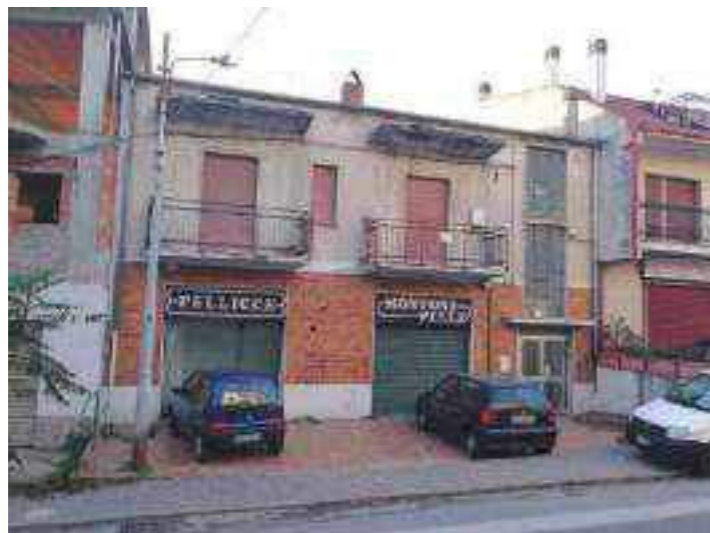
Foto 11A - Vista del prospetto del fabbricato propiciente la Via A. Moro, sulla quale affacciano balconi del piano primo
