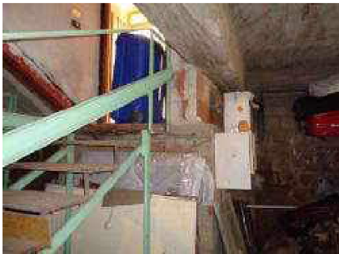
Foto1F – L'ingresso al seminterrato dal vano scala, posto in fondo, visibile anche nella Foto 1B
