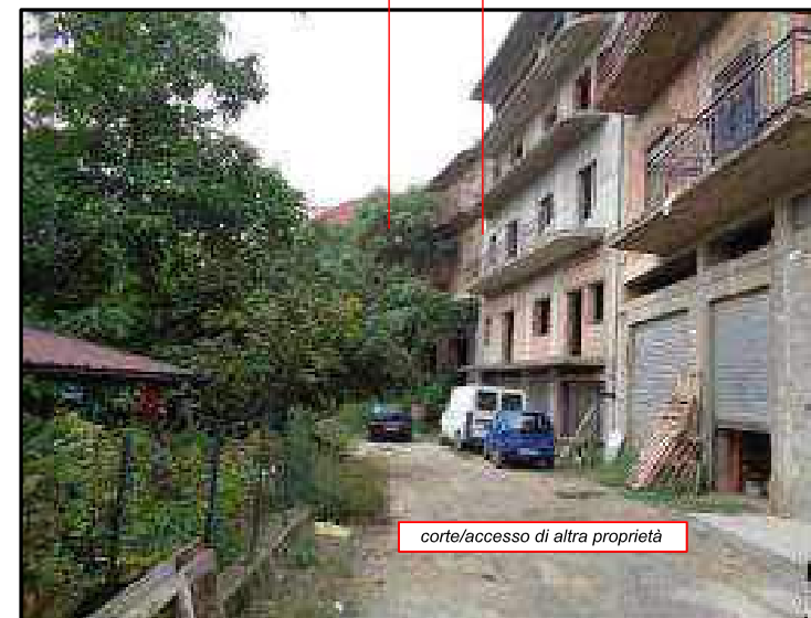
Foto 9A - Vista panoramica della facciata ovest del fabbricato delimitazione del fabbricato
