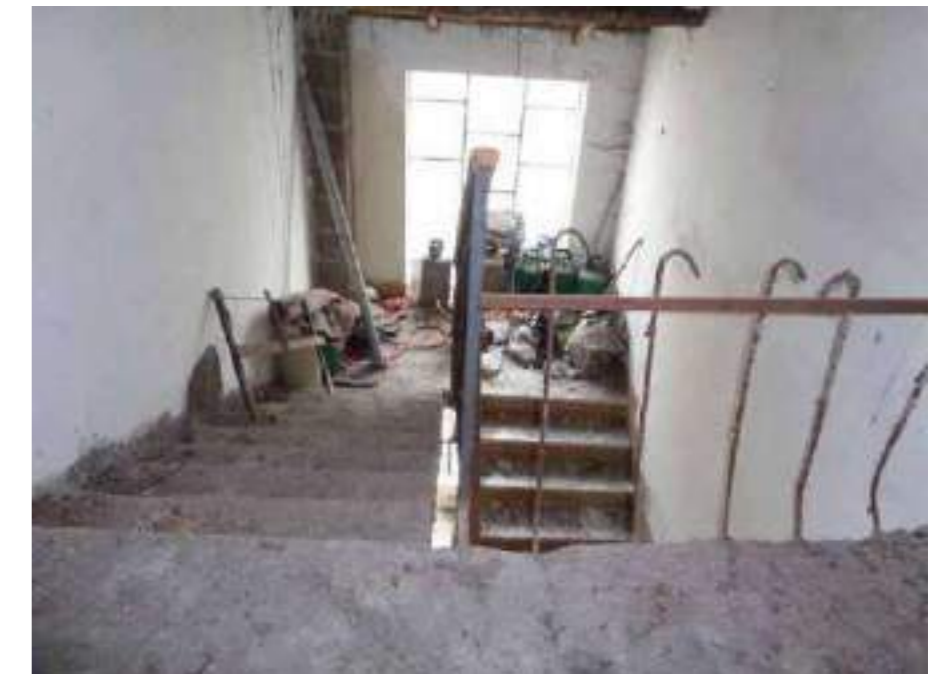
Foto 11Q - Le rampe di scala, allo stato rustico, che portano alla soffitta
