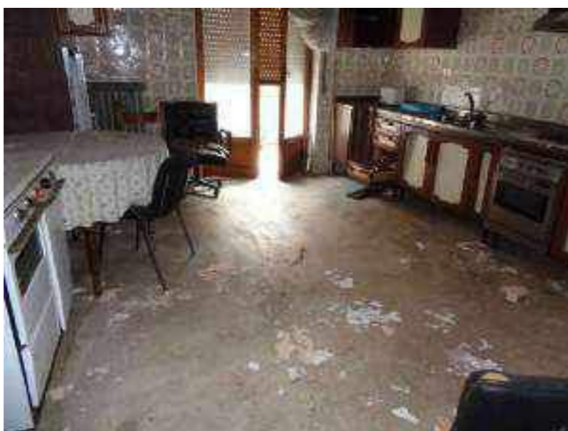
Foto 11G - Il pavimento della cucina cosparso di materiali che si sono distaccati dal soffitto (v. Foto 11F)
