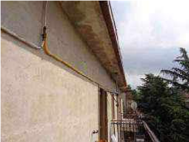
Foto 7I – Vista della pensilina di copertura (degrado materico dell'intradosso)
