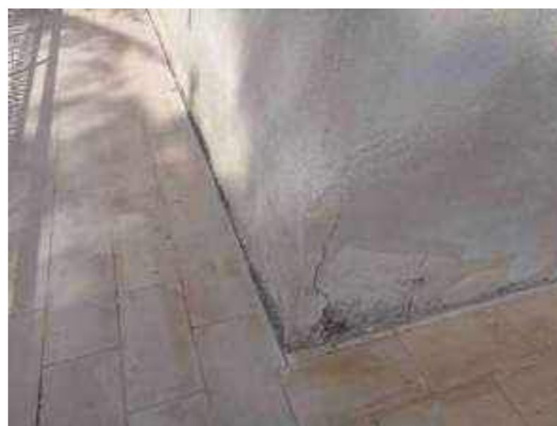
Foto 3N - Pareti esterne prive di battiscopa sul pavimento dei balconi, con distacchi e lesioni dell'intonaco
