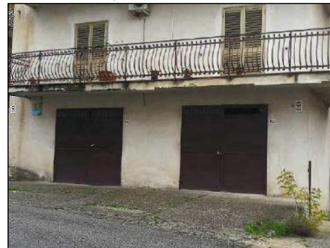
Foto 2A - Vista del fronte est, piano terra, con i due accessi carrabili
