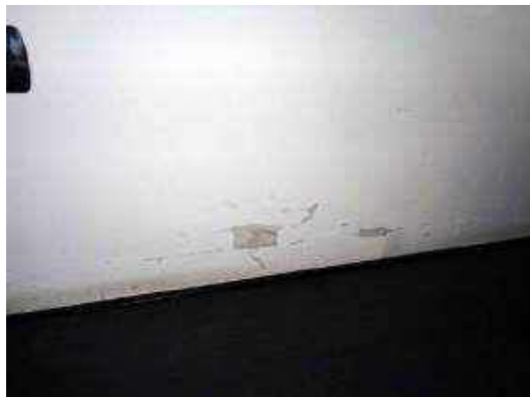
Foto 6L - Stato di degrado del balcone sul fronte nord (marcata umidità da risalita con formazione di muschi)
