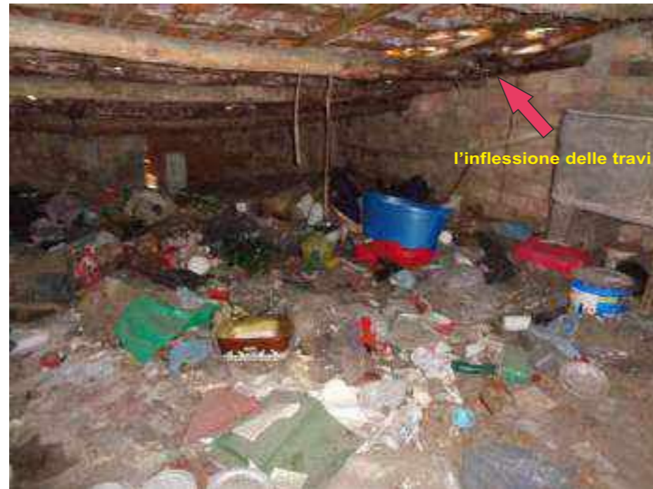
Foto 11L - Stato in cui versa l'interno della soffitta
