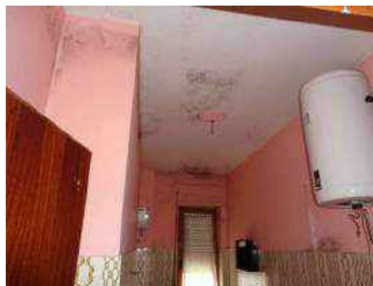
Foto 11H - Umidità da infiltrazioni nel bagno
