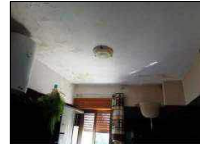
Foto 5D - Il soffitto del bagno con evidenti segni di trascorsa umidità da infiltrazioni
