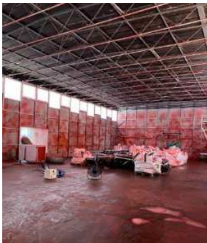
Figura 6 Bonifica amianto e lana minerale intervento 3 A
