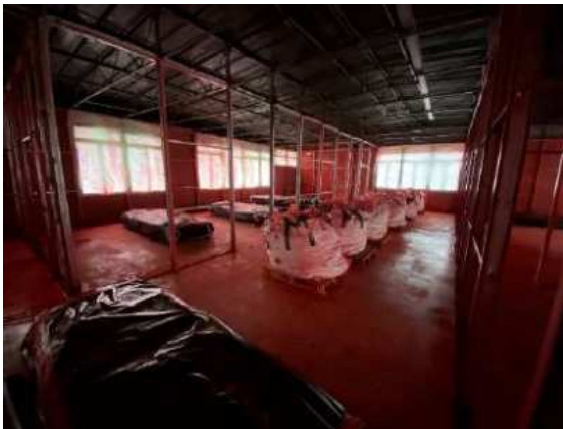
Figura 5 bonifica amianto e lana minerale intervento 2
