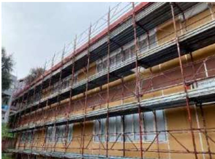
Figura 7 Installazione ponteggio perimetrale
