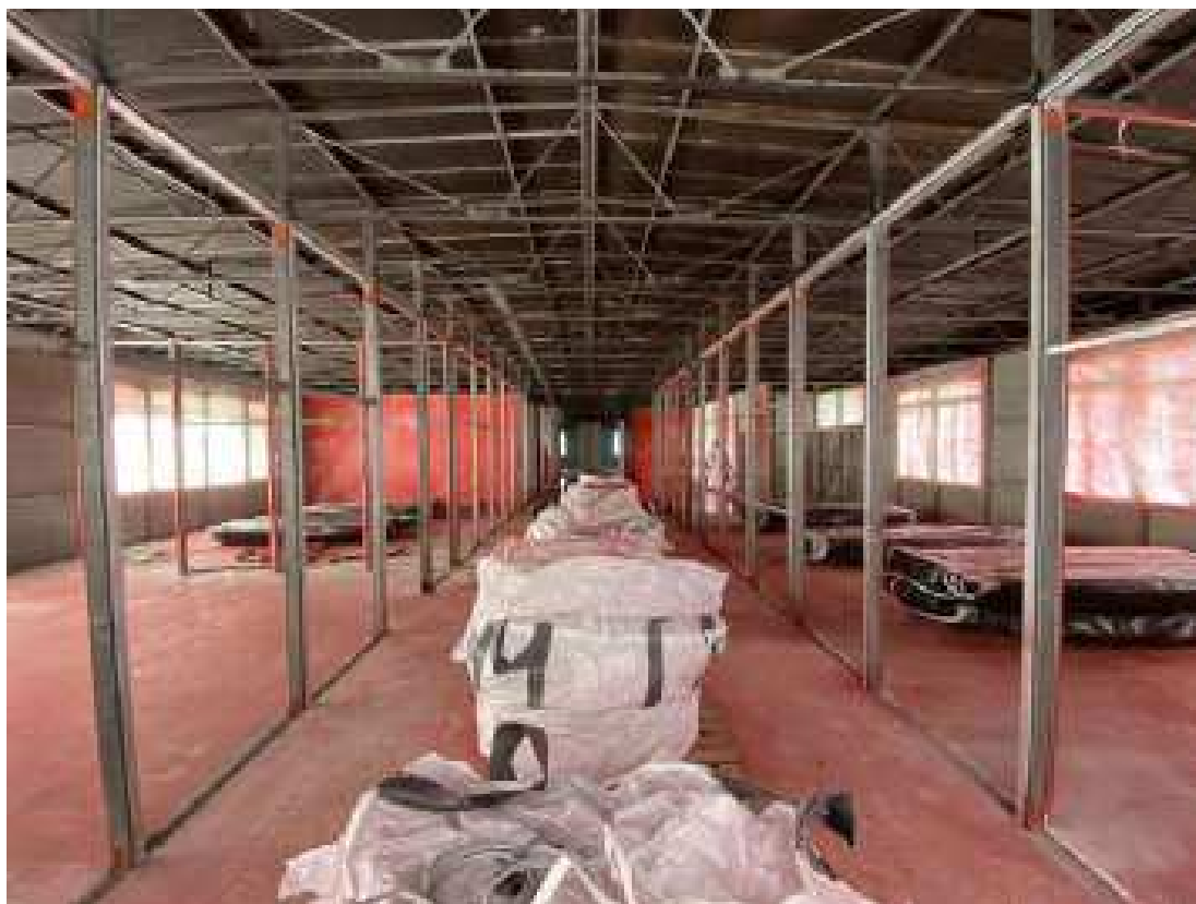
Figura 4 rimozione controsoffitto intervento 2
