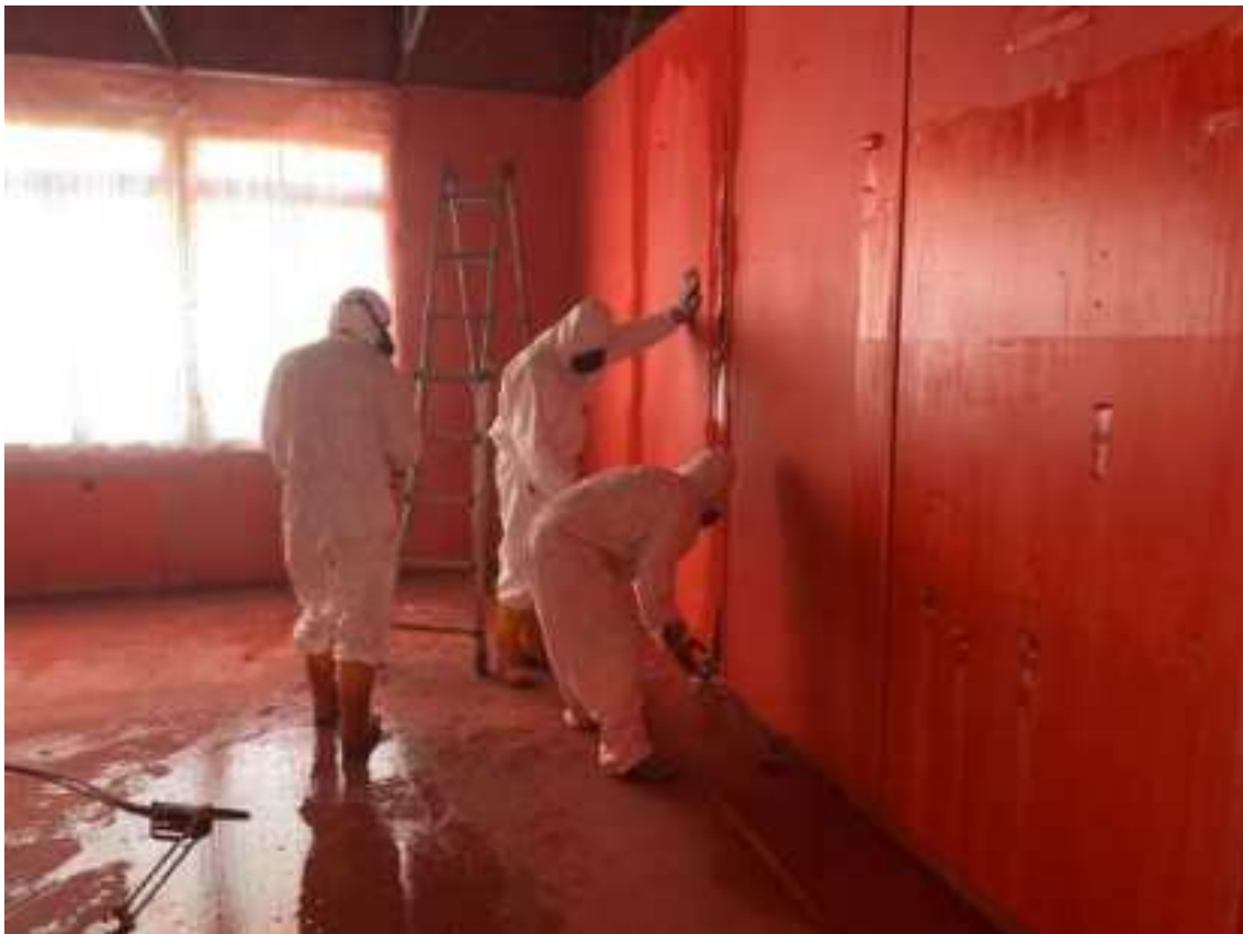
Figura 2 incapsulamento e smontaggio pannelli amianto Salvit intervento 1
