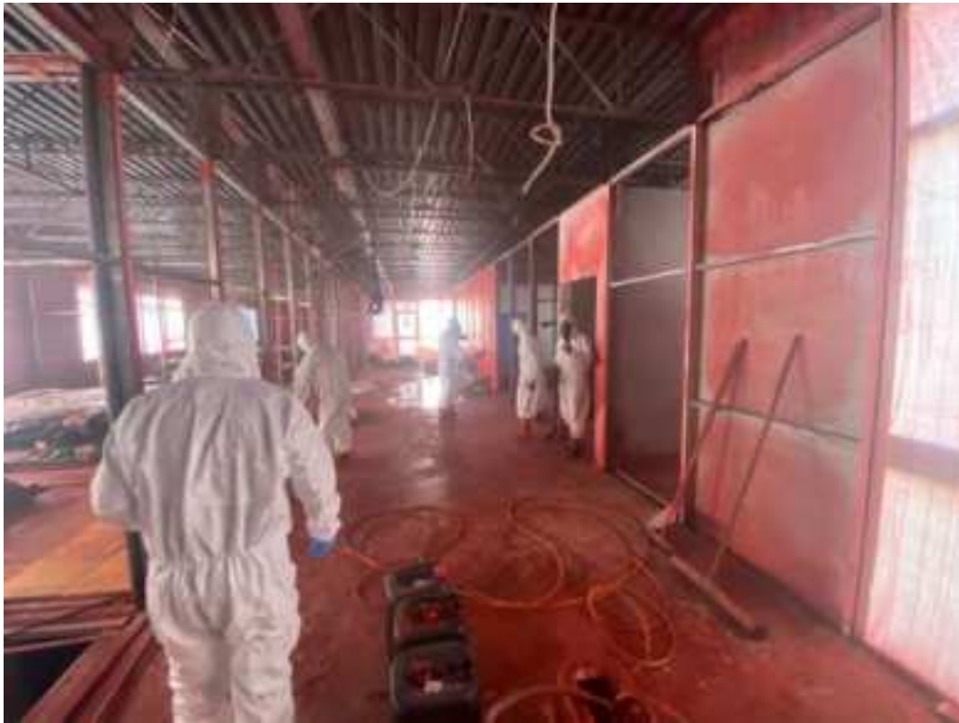
Figura 1 incapsulamento e smontaggio pannelli amianto Salvit intervento 1
