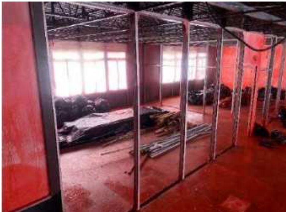
Figura 9 bonifica amianto e lana minerale intervento 3 B
