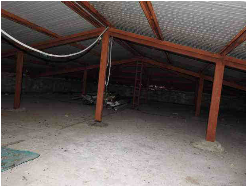
Foto N°29: Vista della struttura metallica di copertura (dir. Ovest)
