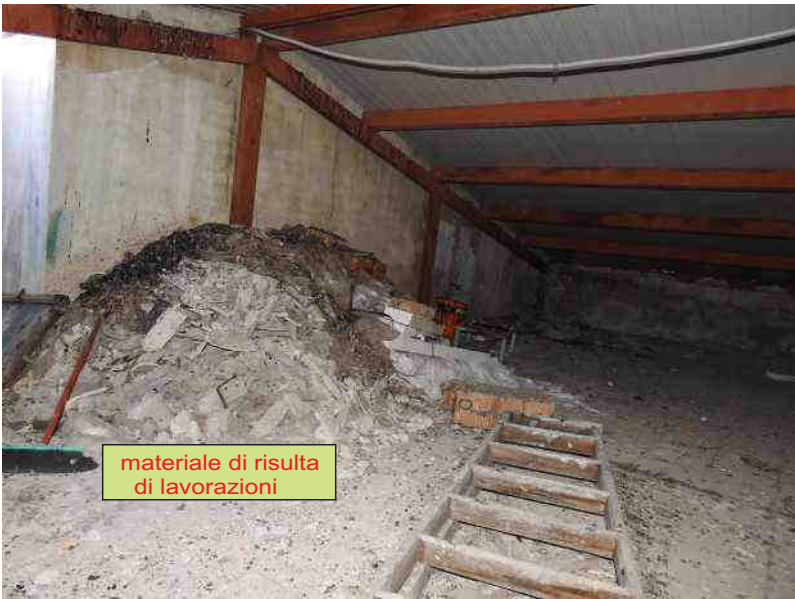
Foto N°30: Vista della struttura metallica di copertura (dir. Sud)
