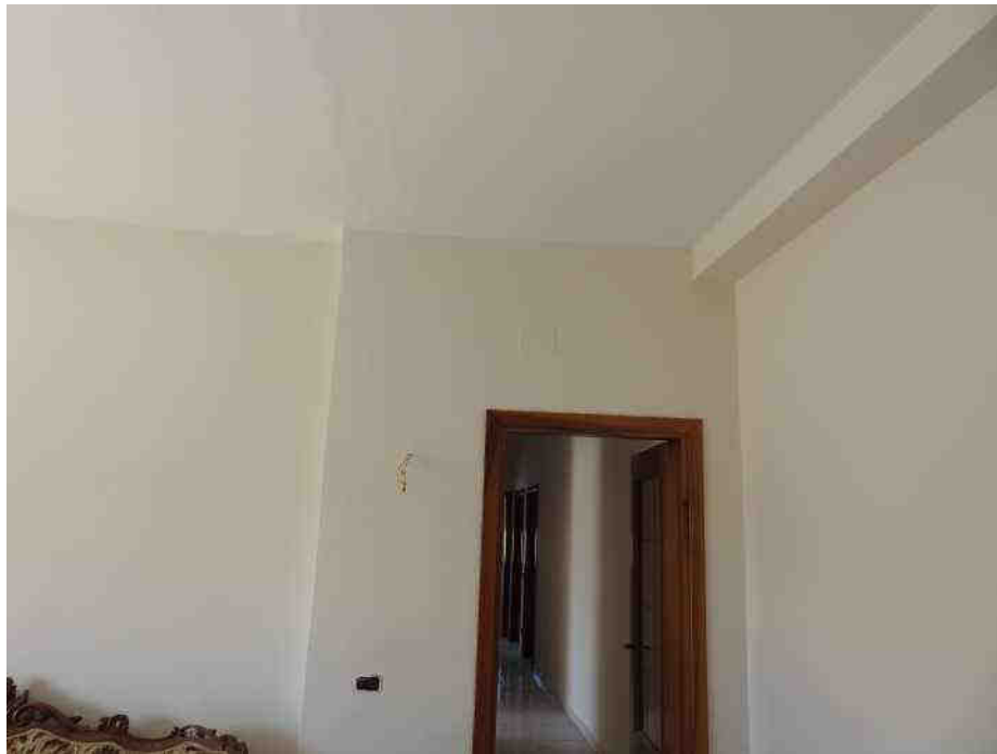
Foto N°1 - PV1: Vista soggiorno (stanza 1)
