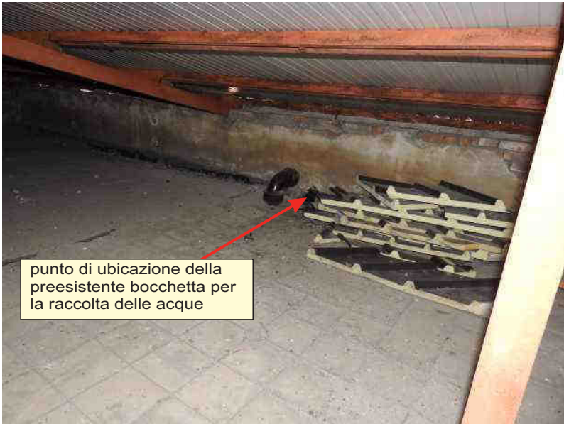
Foto N°34: Vista interna della falda di copertura (dir. Nord)
