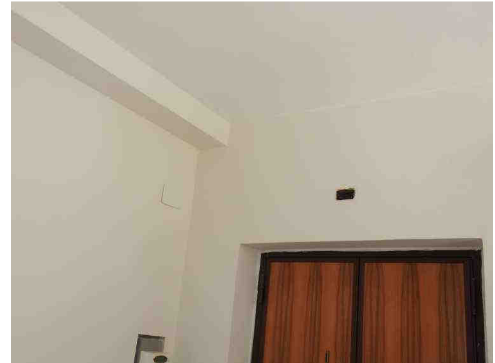
Foto N°3 - PV3: Vista ingresso (stanza 1)
