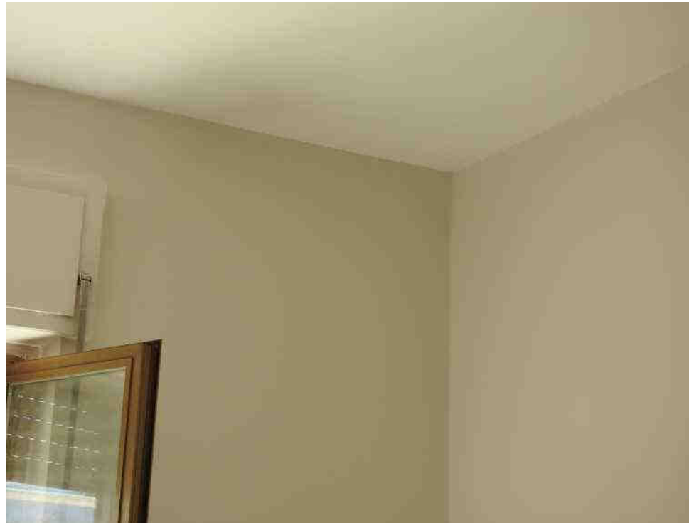
Foto N°2 - PV2: Dettagli soffitto soggiorno (stanza 1)
