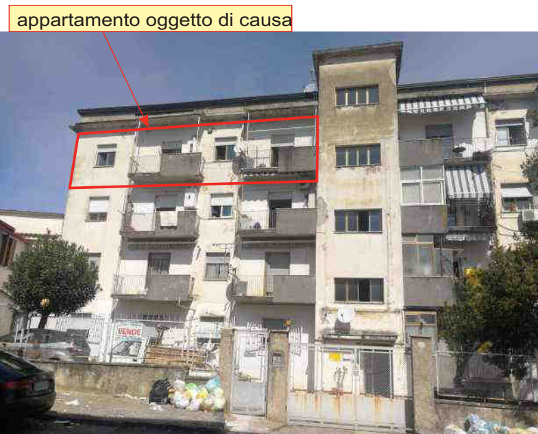
Foto N°26 - PV5: Facciata Sud dell'edificio condominiale
