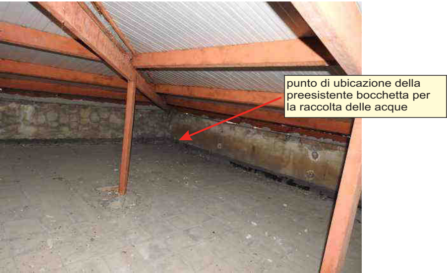
Foto N°35: Vista interna della falda di copertura (angolo Nord-Ovest)
