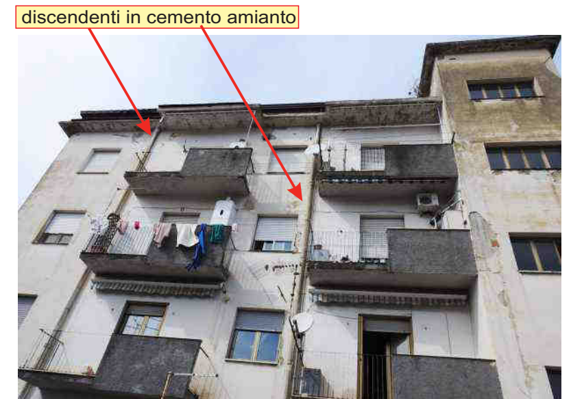
Foto N°28 - PV5: Facciata Sud vista dal basso
