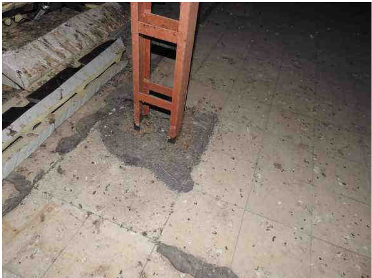
Foto N°33: Particolare ancoraggio del pilastro di foto n°32
