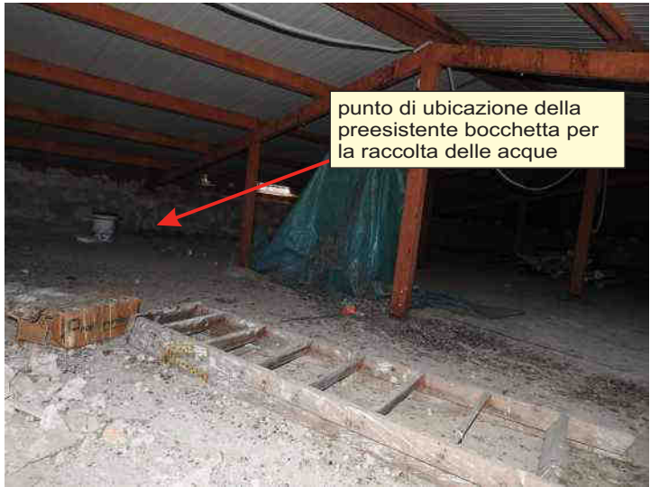
Foto N°36: Vista interna della falda di copertura (dir. Sud)
