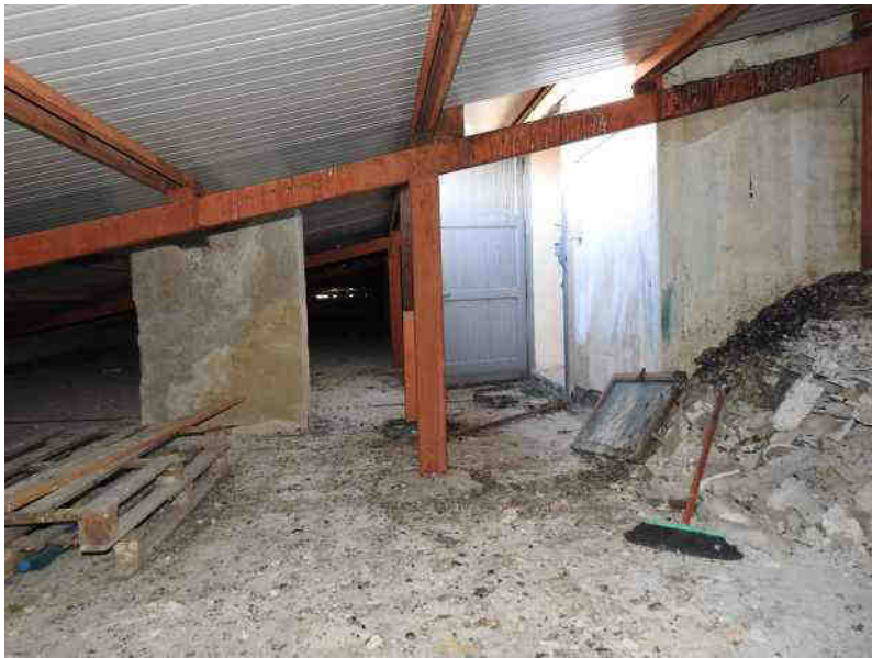
Foto N°31: Vista della struttura metallica di copertura (dir. Est) e del punto di accesso al sottotetto
