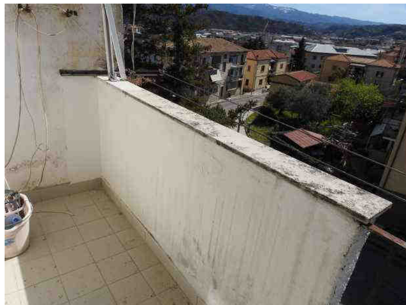
Foto N°23 - PV4: balcone della stanza 1
