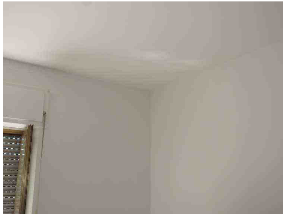
Foto N°5 - PV10: Vista stanza 3
