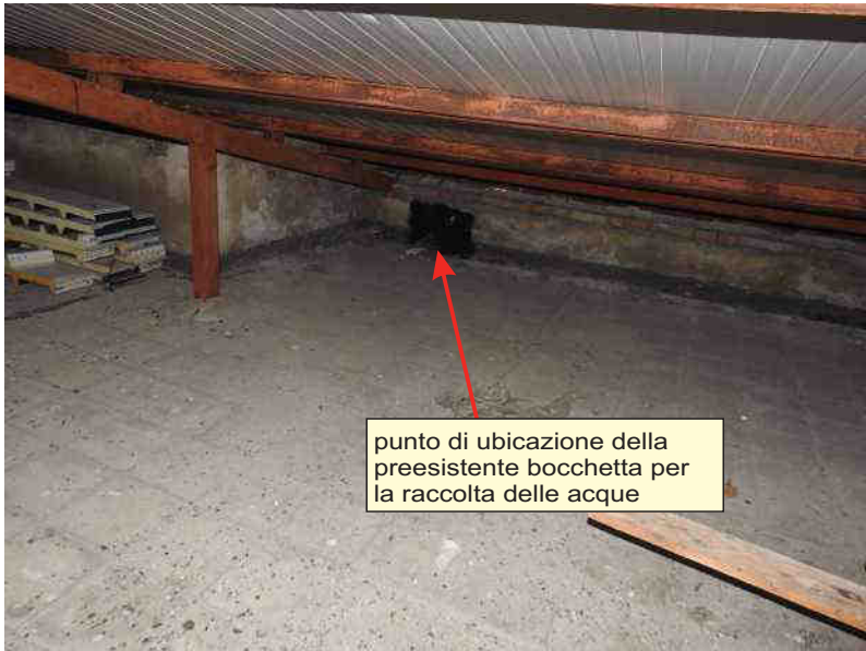
Foto N°37: Vista interna della falda di copertura in corrispondenza dell'appartamento confinante con quello oggetto di causa
