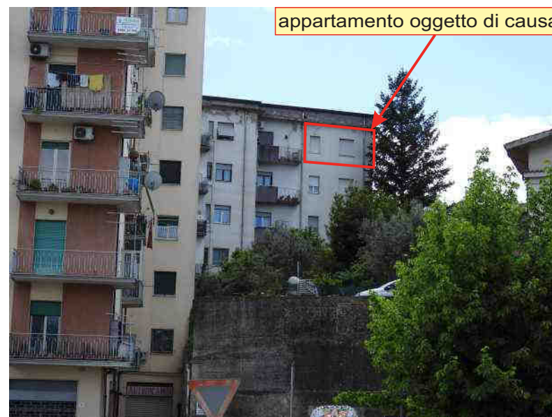
Foto N°27 - PV13: Facciata Nord dell'edificio condominiale
